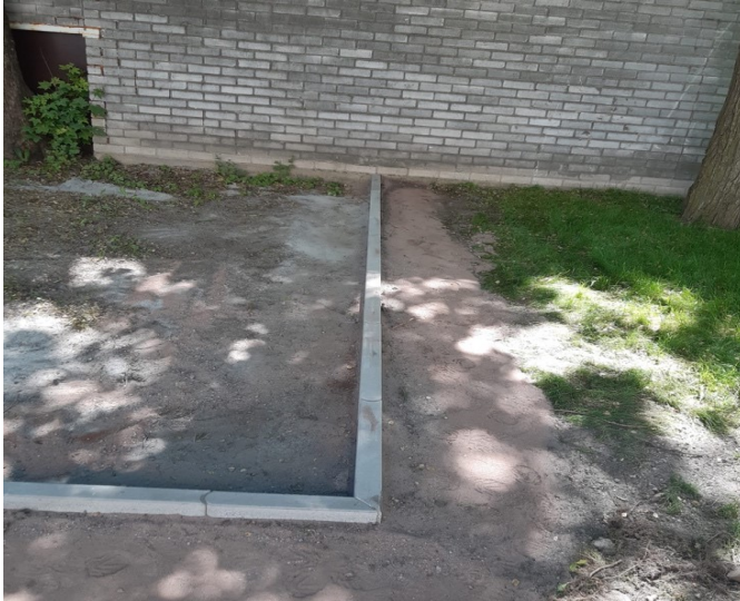
Kuva 9. Asennettu reunakivi nurmikon rajaajana.
