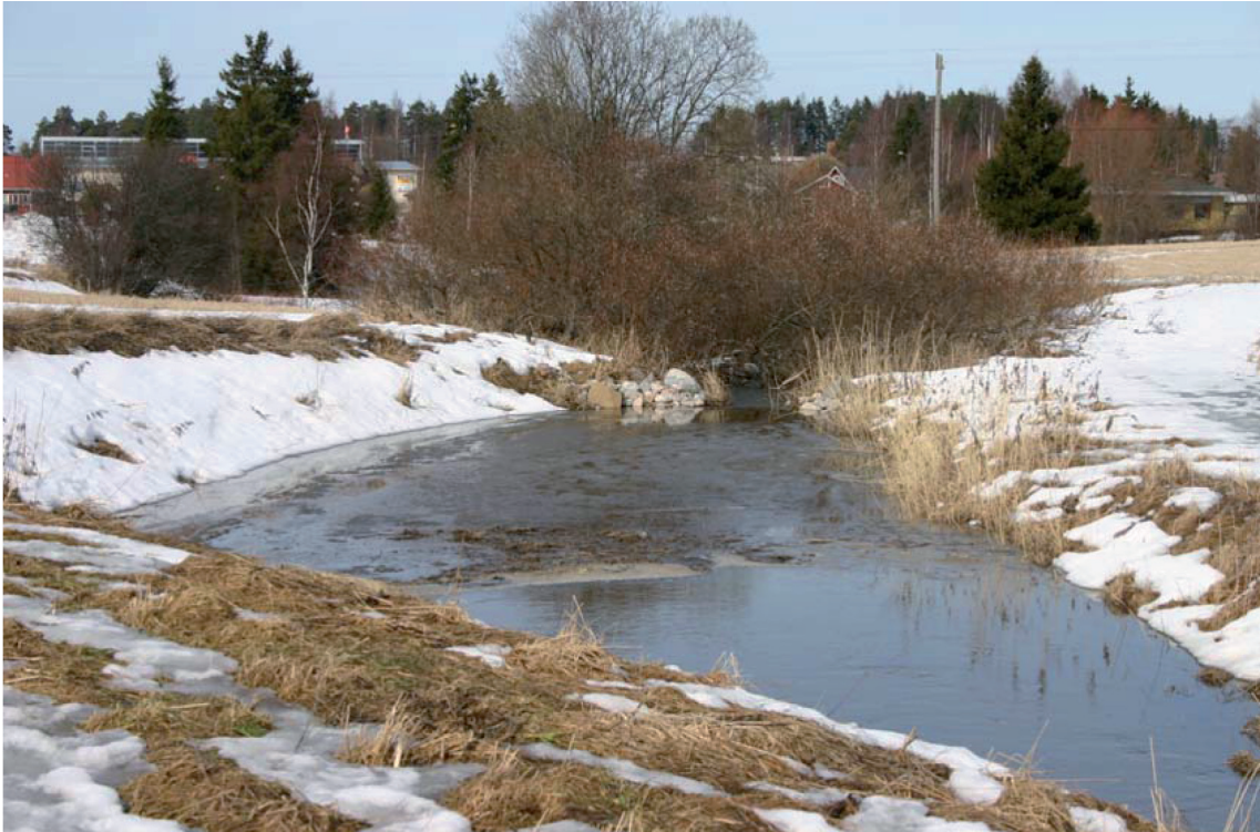
Paattisten kaivamalla ja patoamalla rakennettu laskeutusallas 12.4.2006. Kuva: Hannamaria Yliruusi
