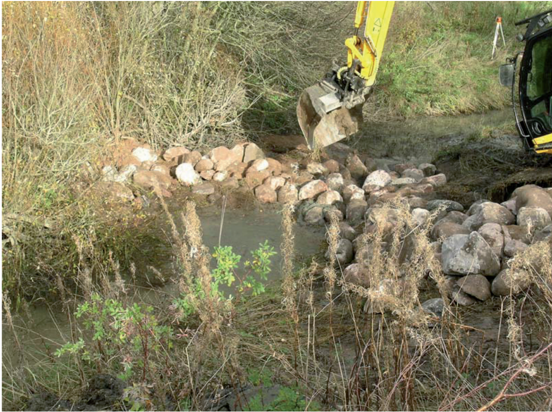
Auran Lahnaojan pohjapadon rakentamista lokakuussa 2005. Kuva: Hannamaria Yliruusi
