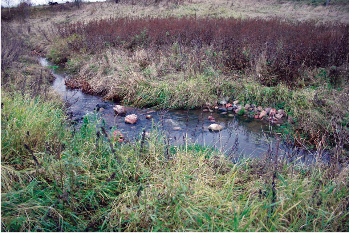
Oripäässä Aurajokeen rakennettiin kolme pienehköä pohjapatoa. Kuva: Heli Kanerva-Lehto
