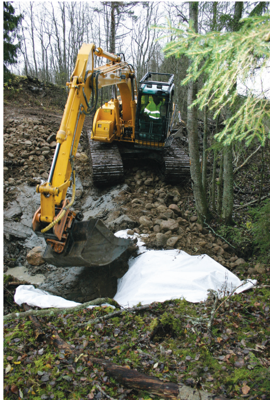
Pöylijokeen laskevan Haapaojan pohjapadon rakentaminen lokakuussa 2007. Kuva: Heli Kanerva-Lehto
