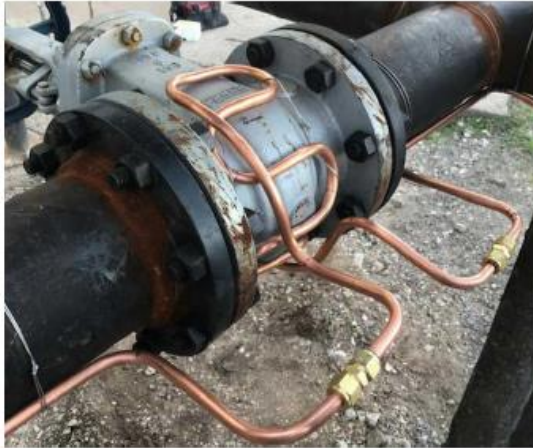
Kuva 5. Pieniä höyrysaattoputkia lämmitettävän putken ympärillä. [14, s.38.]
