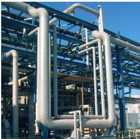
Kuva 11. Alaspäin rakennettu paistuntalenkki [9].
