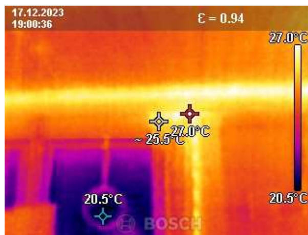
Kuva 25. Lämpökamerakuva keittiön katonrajasta
