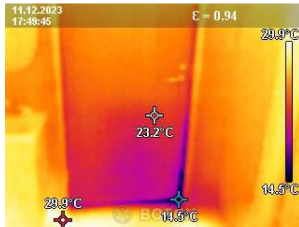
Kuva 18. Lämpökamerakuva kylpyhuoneen ulko-ovesta
