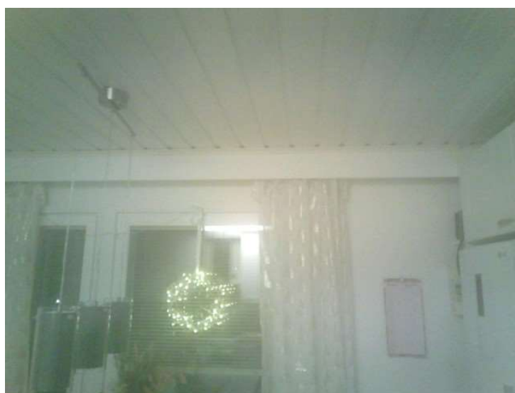
Kuva 26. Kuva keittiön katonrajasta
