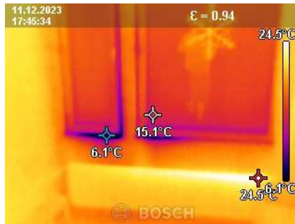
Kuva 14. Vierashuoneen ikkunat ja patteri lämpökameralla kuvattuna
