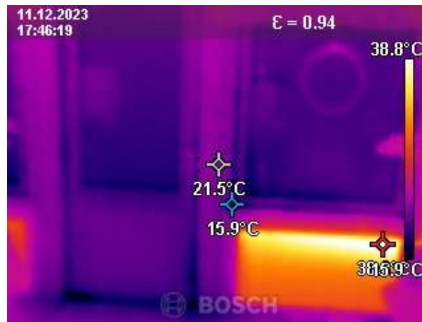
Kuva 16. Olohuoneen ulko-ovi, sekä patteri lämpökameralla kuvattuna
