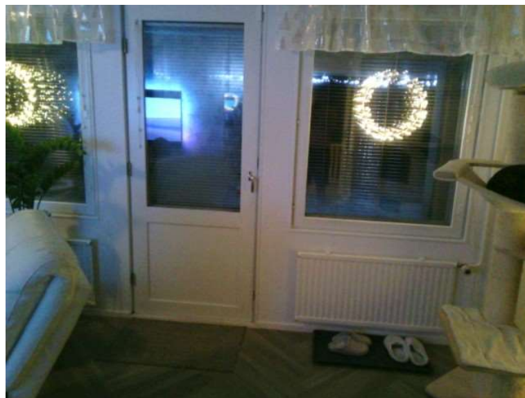
Kuva 17. Yleiskuva olohuoneen ovesta ja patterista
