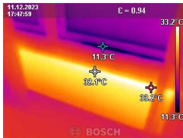
Kuva 15. Makuuhuoneen patteri lämpökamera kuvattuna
