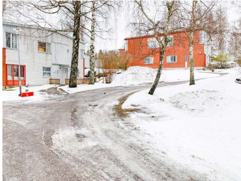
Kuva 2. Myllärintie 10:n etelärinteeseen nouseva serpentiinimäinen tie ja sen varrella olevia rakennuksia.
