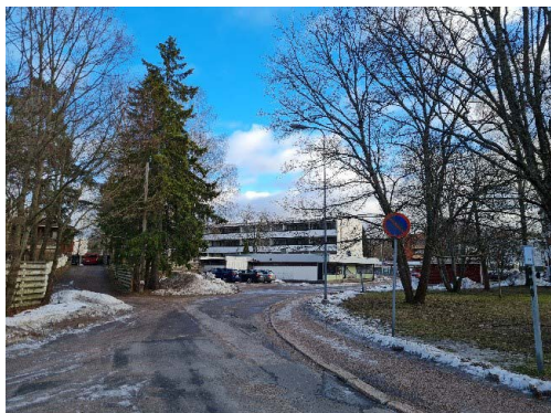
Kuva 2. Näkymä rakennuspaikalle ja purettava liikerakennus.
