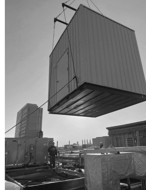
Kuva 1. Väistötilojen rakentamisessa elementtituotannon hyödyntäminen on avainasemassa. Kuva: safespacebuilding.com
