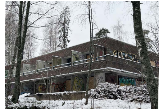
Kuva 2. Valokuva entisen majoitusrakennuksen lähtötilanteesta. Kuva on otettu 19.01.2023.
