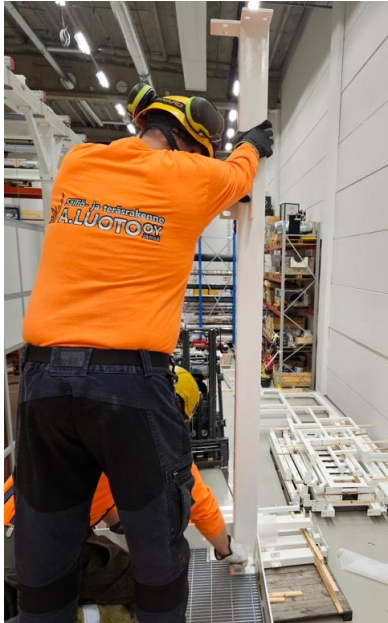
Kuva 18. Toisen kerroksen pilari.
