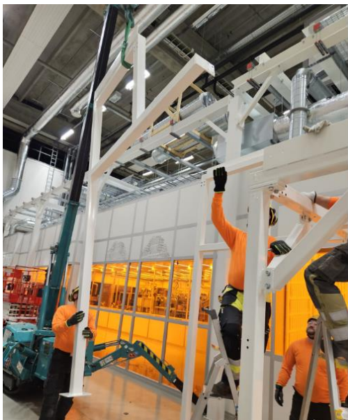
Kuva 11. Portaiden tukien asentaminen.
