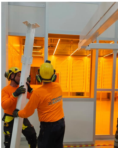
Kuva 6. Asentajat kantamassa pylvästä.
