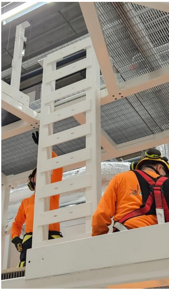
Kuva 29. Reaktorin runko valmiiksi asennettuna.
