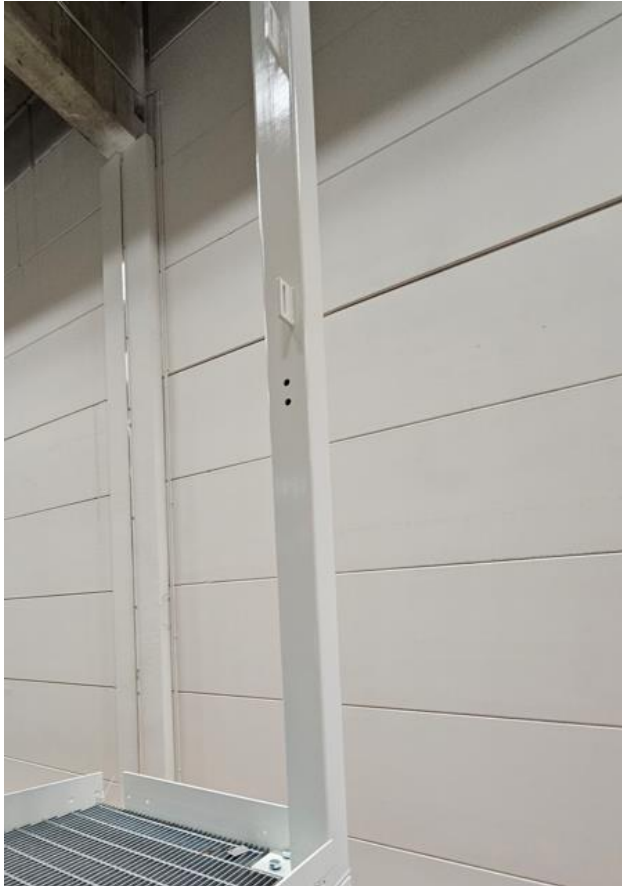
Kuva 26. Kolmannen kerroksen pilari.
