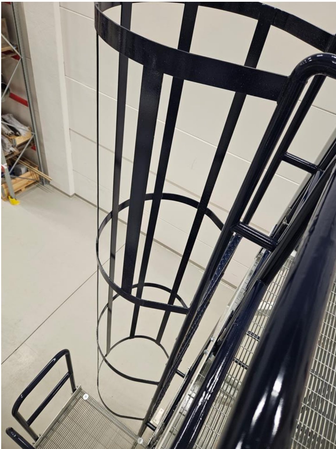
Kuva 37. Toisen reaktorin rungon hätäpoistumistie.
