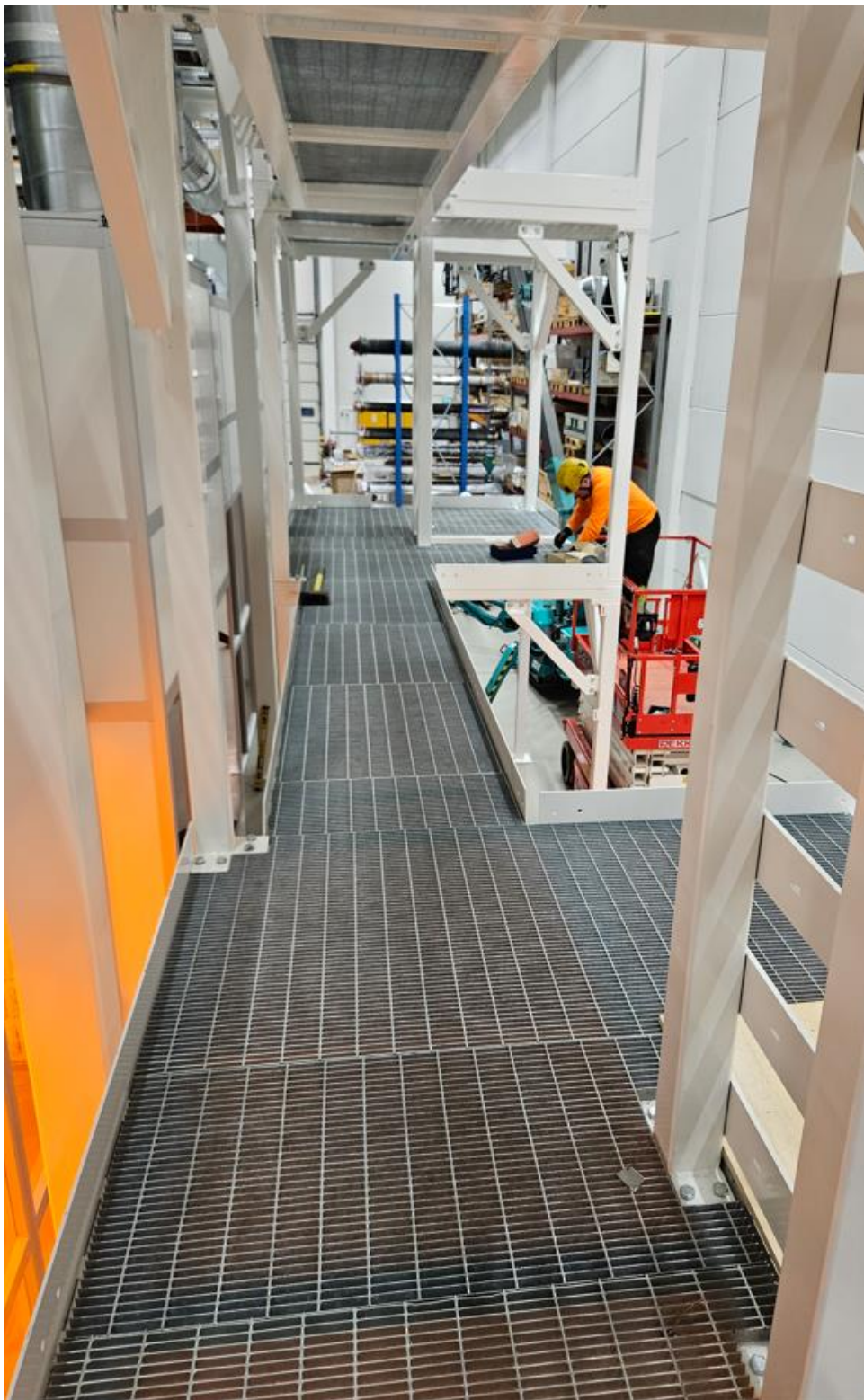
Kuva 36. Rungon silta ylhäältä kuvattuna.
