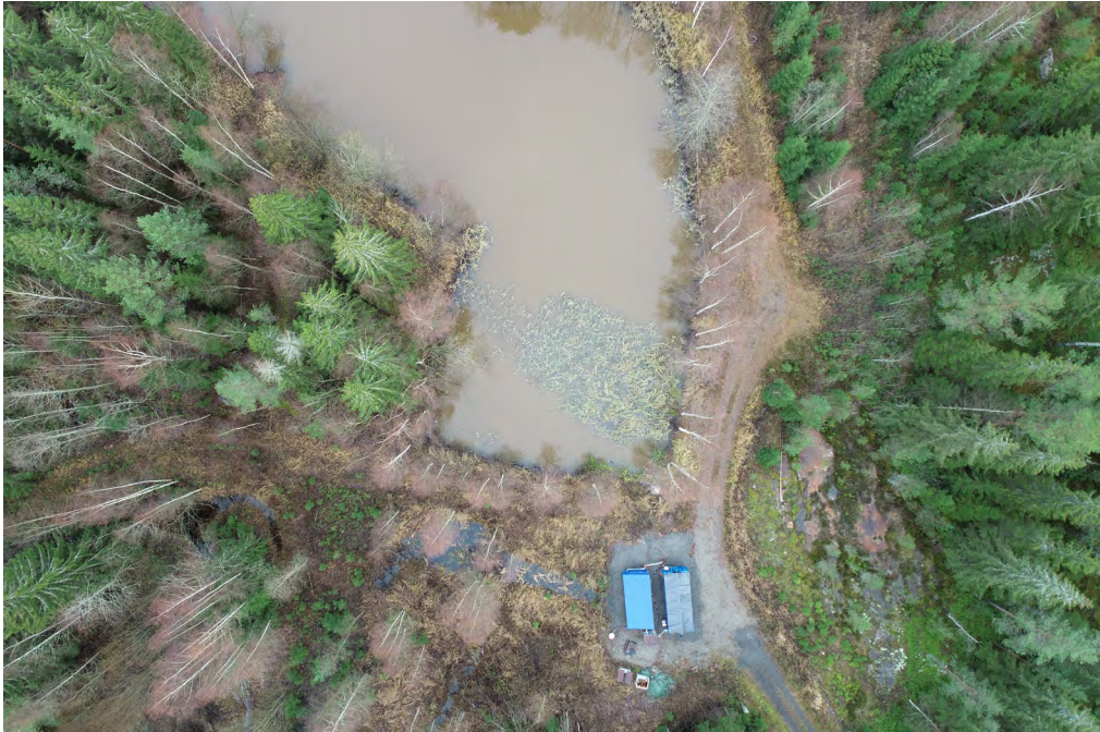
Kuva 1. Ristiinan pilottijärjestelmä sijaitsee jätetäytön ja suotoveden tasausaltaan välissä (kuva Henri Kettunen).
