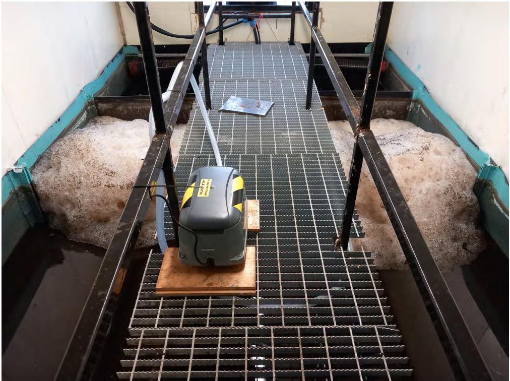
Kuva 21. Suotoveden hapetukseen asennettiin tehokkaampi ilmastinkompressori ja diffuusioilmastinputki (kuva Salla Pulliainen).
