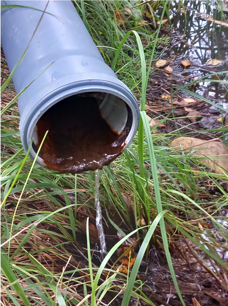
Kuva 2. Suotovedestä laskeutunutta sakkaa on kerääntynyt järjestelmän poistoputkeen saakka käsiteltävän veden esilaskeutuksesta huolimatta (kuva Salla Pulliainen).
