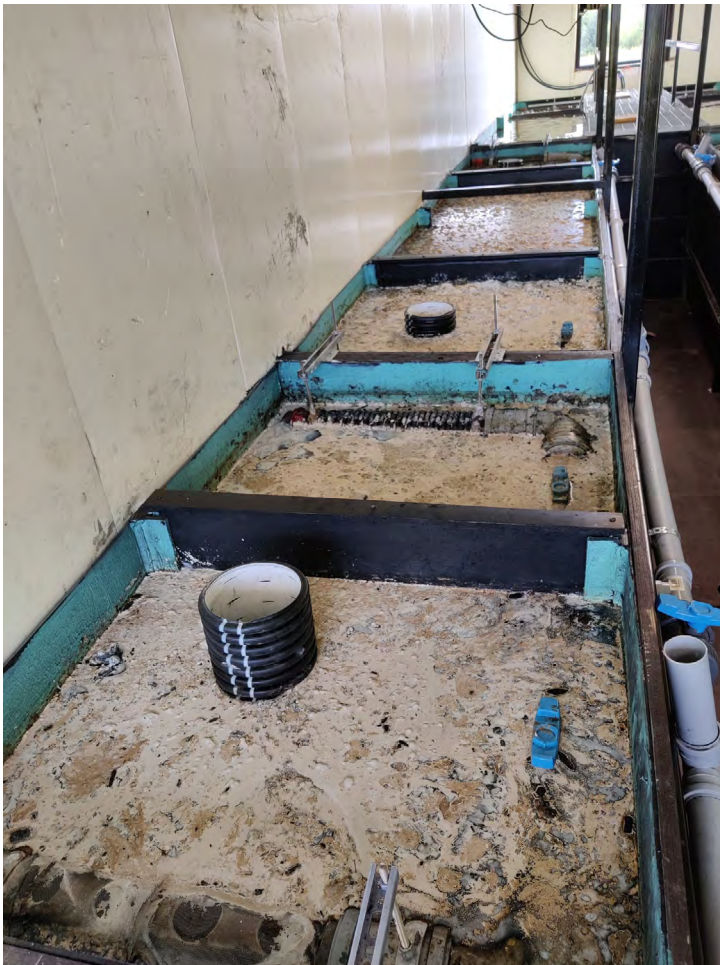
Kuva 20. Suodatinaltaiden pinnalle muodostunutta biofilmiä (kuva Sofia Nokia).
