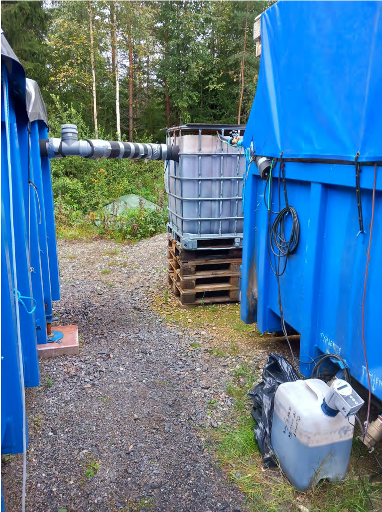
Kuva 10. Aktiivilietteen annostelupumppu raudanpoistoyksikön ja bioreaktorin välissä (kuva Salla Pulliainen).
