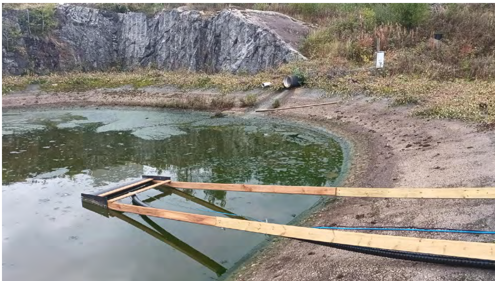
Kuva 3. Devo-hankkeen aikana demonstraatioympäristöön pumpattiin vettä suotovesialtaasta (kuva Salla Pulliainen).
