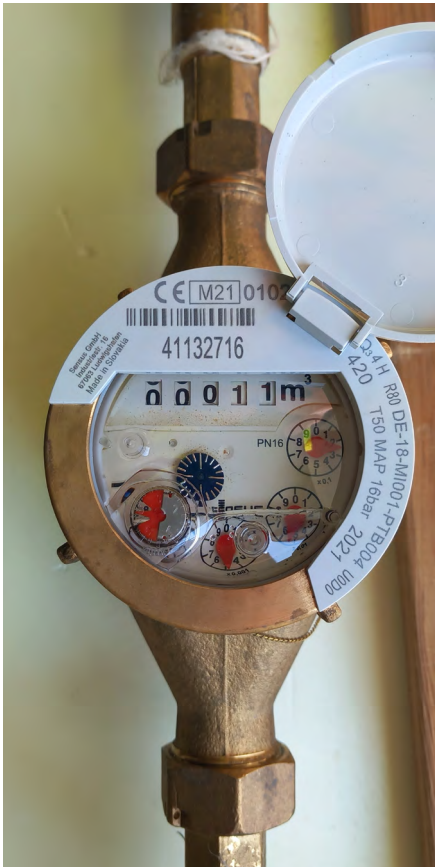
Kuva 9. Kuvassa järjestelmän kokonaisvirtaaman monitorointiin käytetty vesimittari (kuva Matti Hämäläinen).
