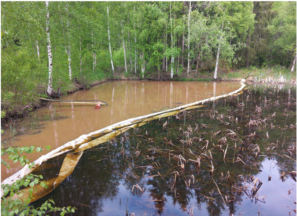
Kuva 3. Tasausaltaan vesi jaettiin kahteen osioon suodatinkankaalla. Kuvassa jakolinjan vasemmalla puolella on pilottijärjestelmän pumppu. Pilottijärjestelmän purkuputki johtaa tasausaltaaseen suodatinkankaan oikealle puolelle (kuva Salla Pulliainen).
