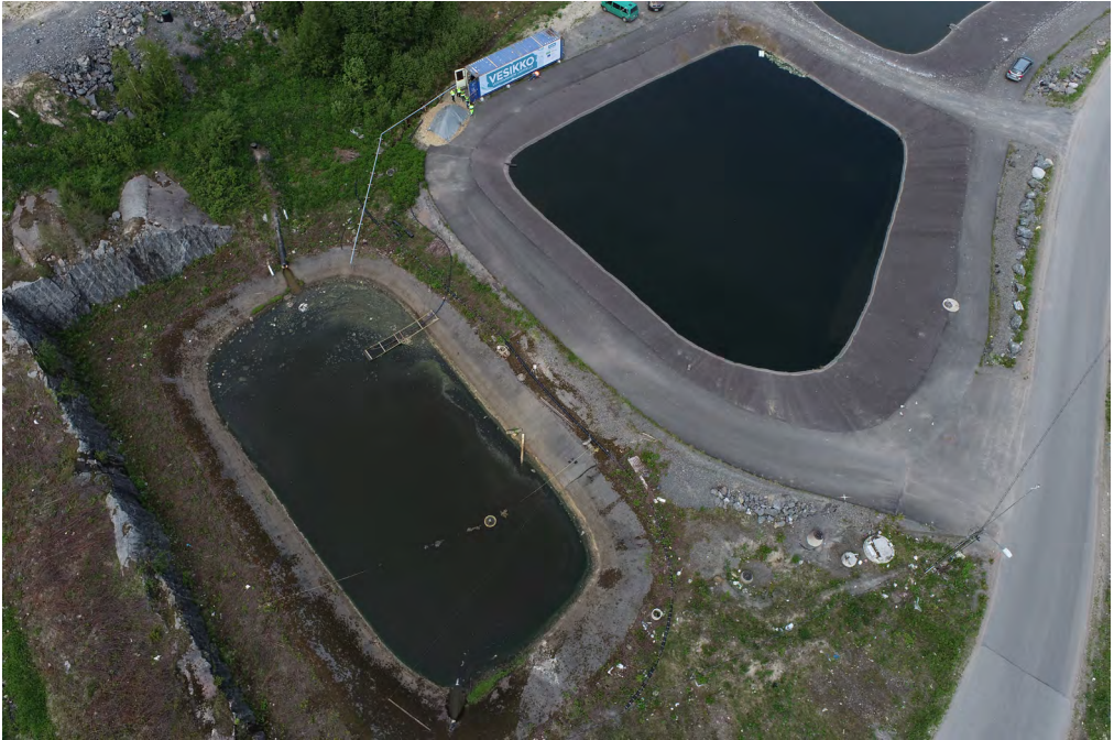
Kuva 2. Demonstraatioympäristö Vesikko sijaitsee Metsäsairilan lajittelu- ja kierrätyskeskuksen alueella suoto- ja hulevesialtaiden vierellä (kuva Henri Kettunen).
