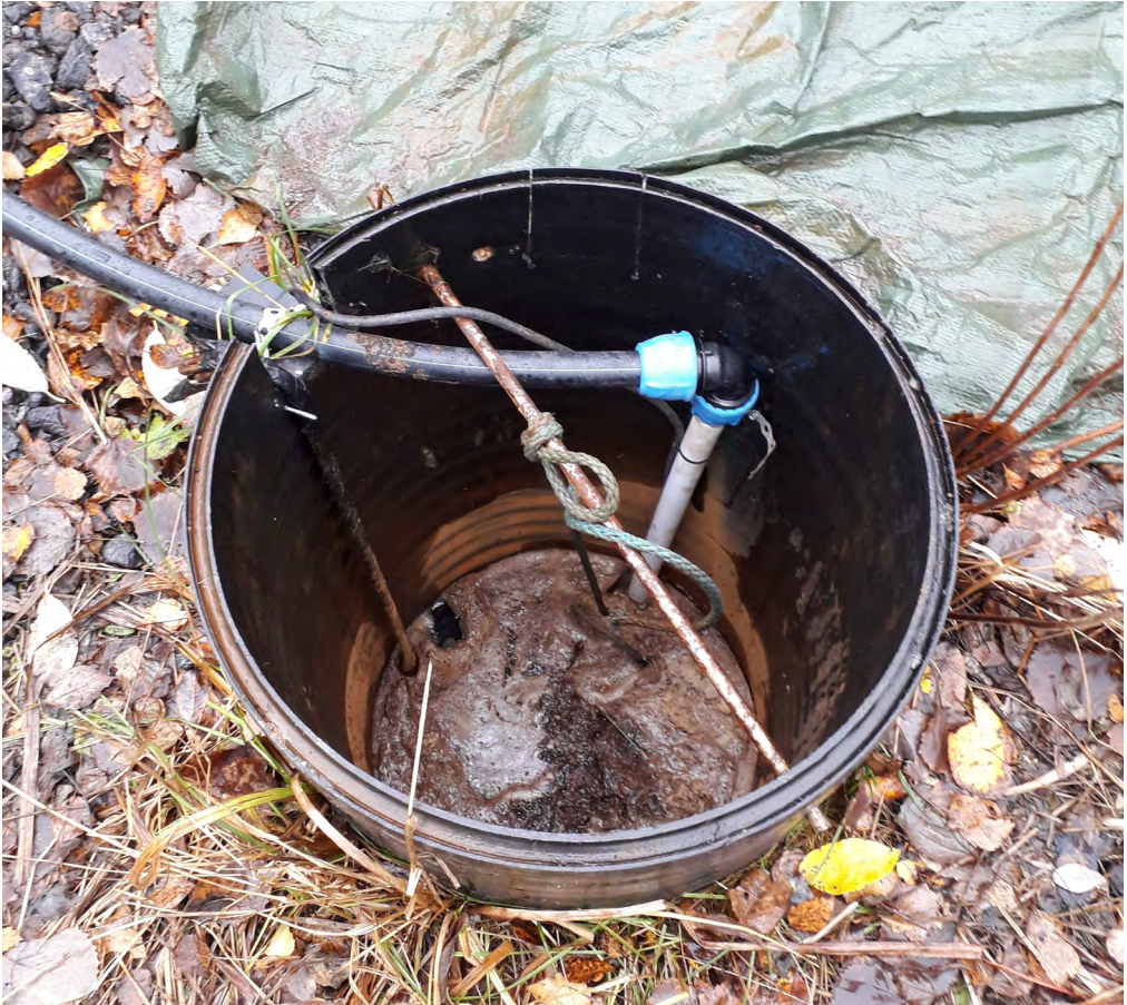
Kuva 2. Vuosien 2021–2022 kokeissa suotovettä pumpattiin raudanpoistoyksikköön suotoveden tulokaivosta (kuva Salla Pulliainen).
