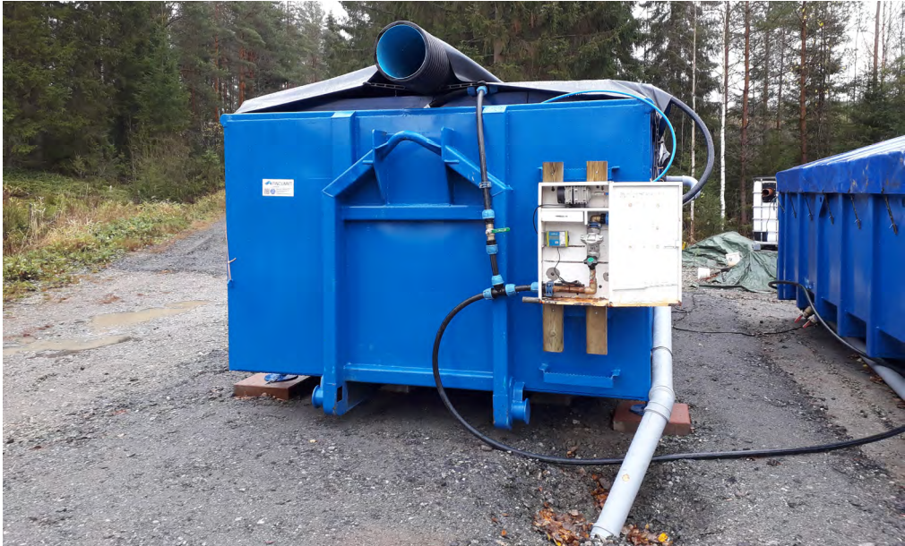
Kuva 3. Syksyllä 2021 käyttöön otettu raudanpoistoyksikkö (kuva Salla Pulliainen).
