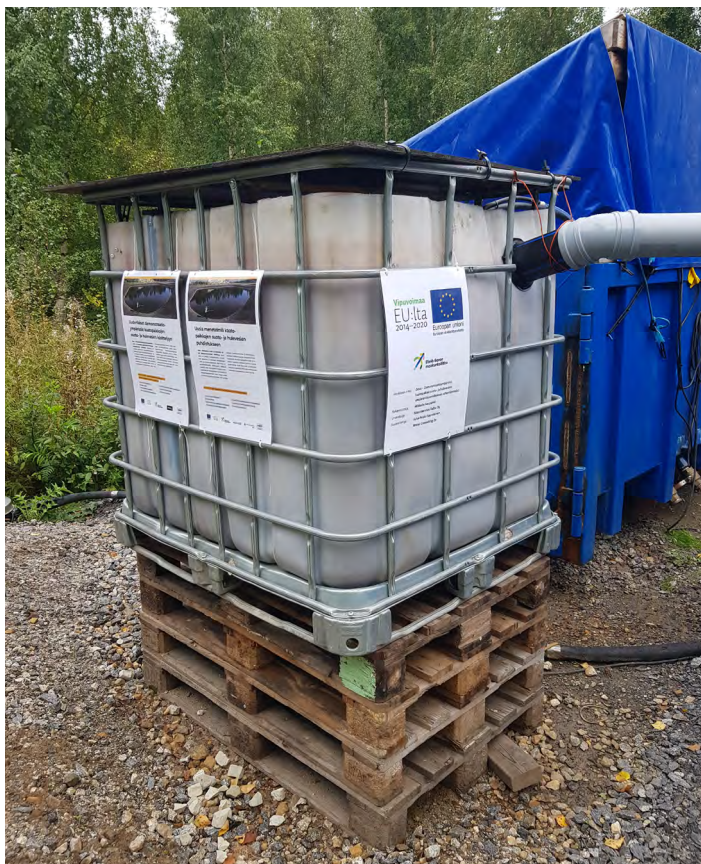
Kuva 5. Kantoaine- ja ilmastusyksikkönä toimii IBC-kontti (kuva Salla Pulliainen).
