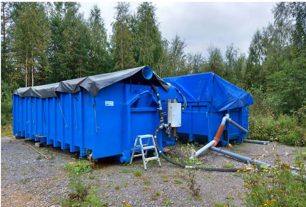
Kuva 7. Kuvassa vasemmalla on raudanpoistoyksikkö ja oikealla bioreaktori. Purkuputki johtaa bioreaktorista tasausaltaaseen (kuva Salla Pulliainen).
