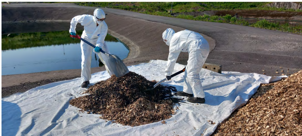
Kuva 2. Linjan 1 suodatinmateriaalit sekoitettiin manuaalisesti lapiolla (kuva Matti Hämäläinen).
