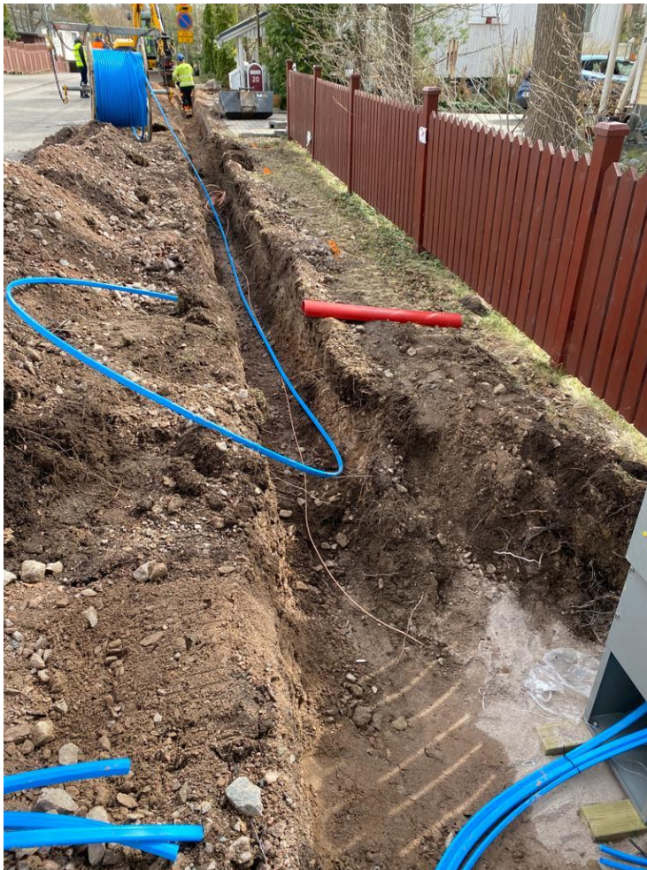
Kuva 9. Mikrokanavan asennus kaapeliojaan (kuva A. Perälä)
