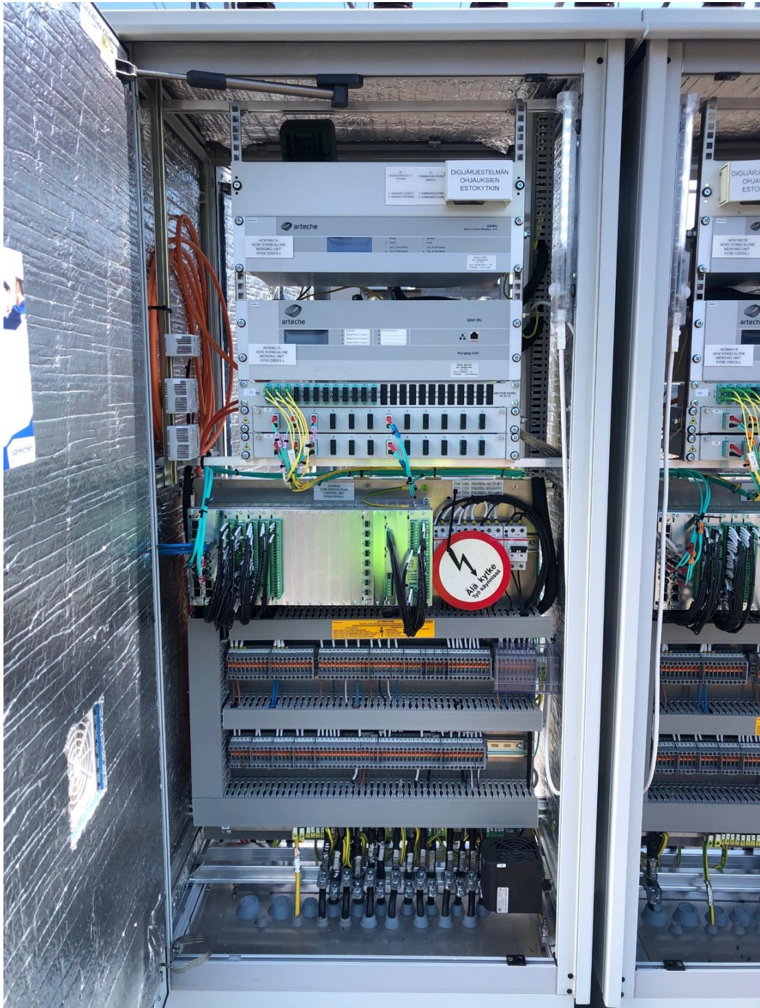
Kuva 2. Laitteiden apujännitesyöttöjen avaus ja älä kytke -kilven asennus
