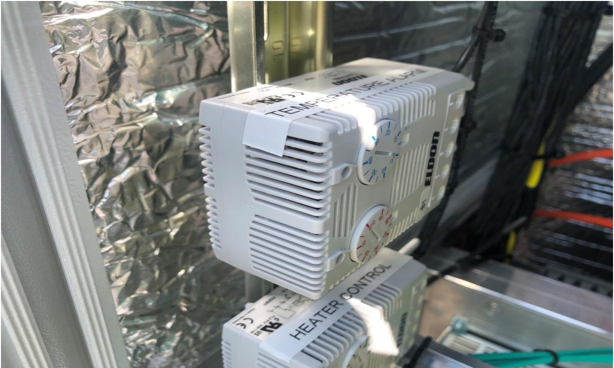
Kuvio 22. Kaksoistermostaatti lämpötilan ylä- ja alarajahälytyksille
