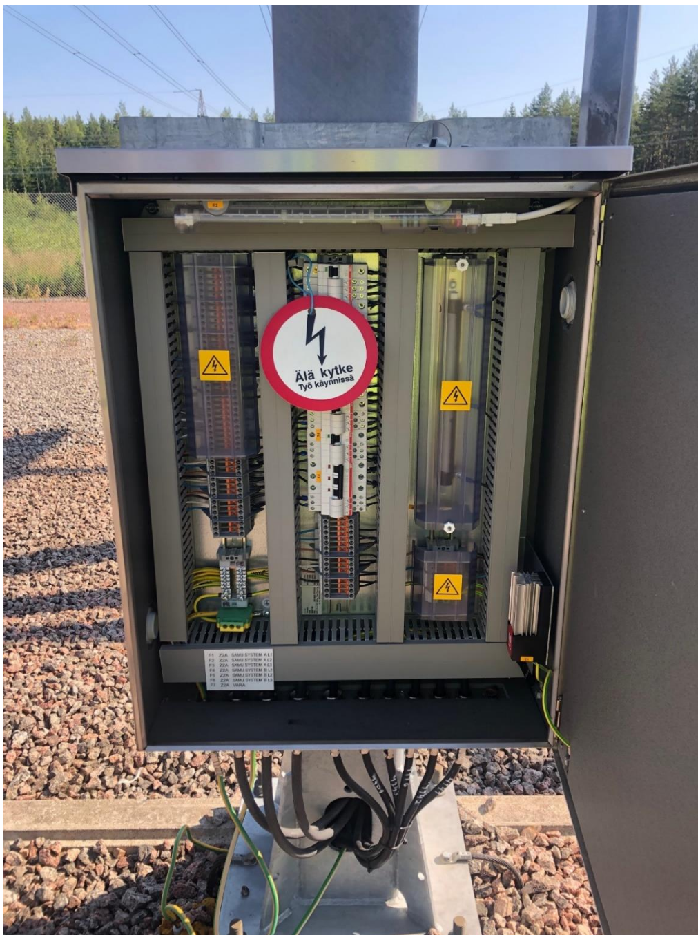
Kuva 1. Älä kytke -varoituskilven asennus
