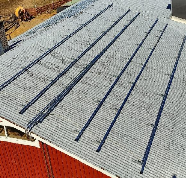
Kuvio 4. 1-kerrostelineessä on vain yhdessä tasossa olevat alumiiniprofiilit. Tähän telineeseen aurinkopaneelit tulevat pystyyn lappeen suuntaisesti. (Galleria 2023.)
