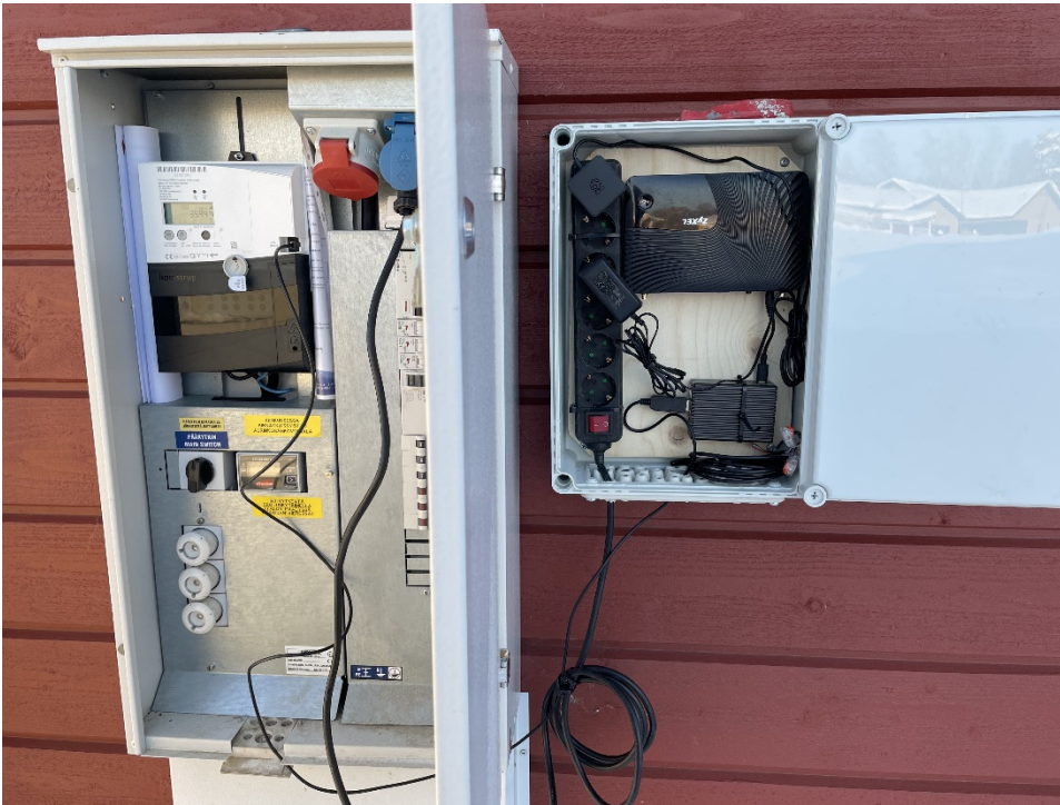
Kuva 15. HAN-väylään kytketty USB-sovitin, Raspberry 4 tietokone ja 4G-reititin omakotitalon sähkökeskuksen yhteydessä.
