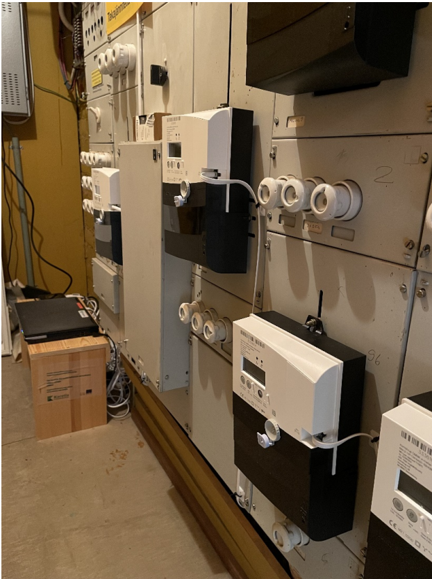
Kuva 16. Pilottikohteen sähkömittarit.
