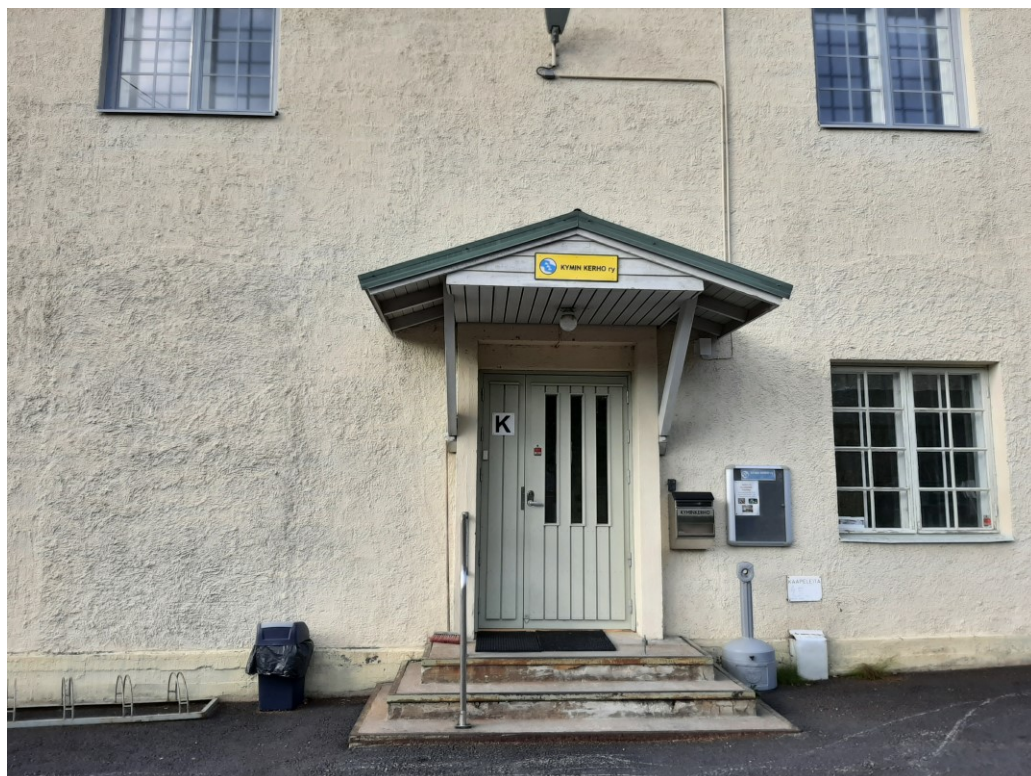
Kuva 14. Alakerran sisäänkäynti Tallinmontussa
