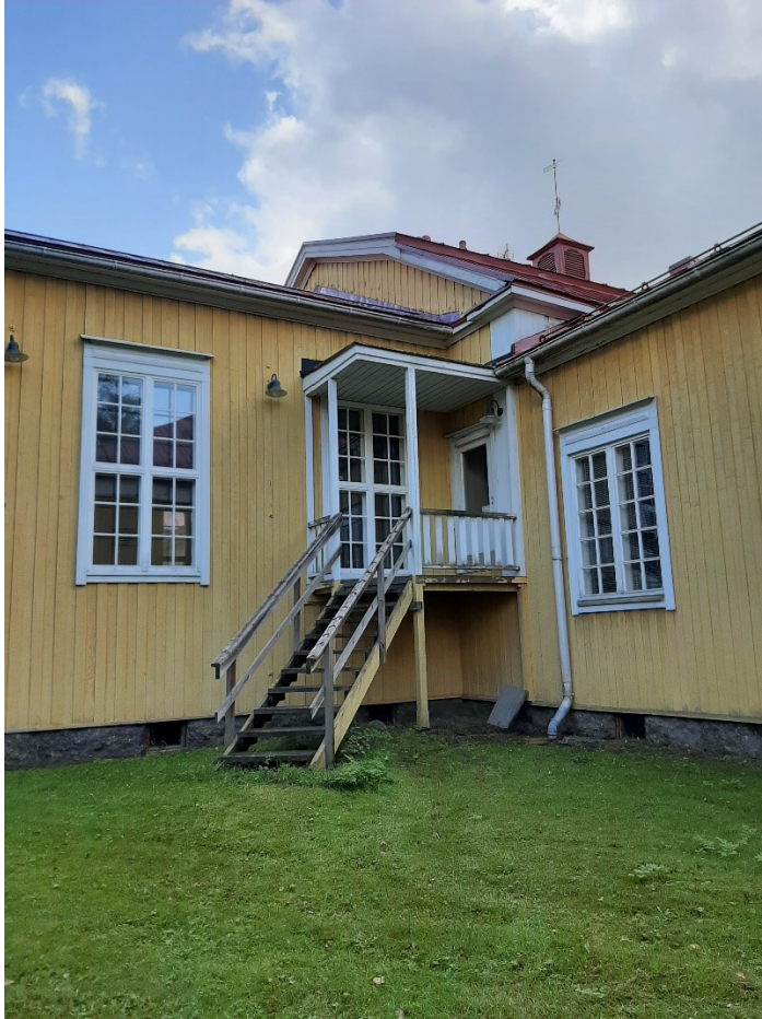
Kuva 11. Sisäänkäynti Pilkan koulurakennuksessa
