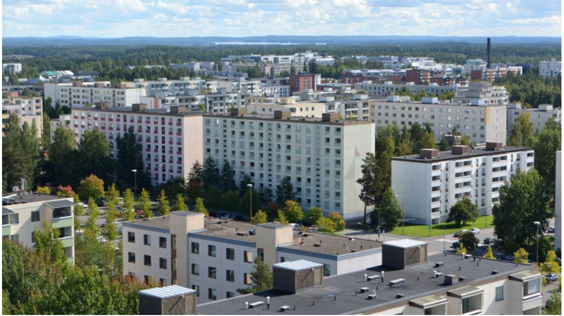
Kuva 2. Petri Aaltosen kuvassa Hervannan kerrostalolähiöstä ilmentyy hyvin 1960–1970-luvuille tyypillinen elementtirakentaminen. Tavoitteena oli rakentaa nopeasti ja edullisesti. (Kuva: Aaltonen 2016)
