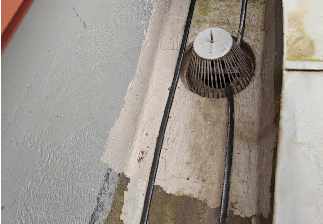
Kuva 27. Kaivon ympärys käsitelty Elaproof aineella.
