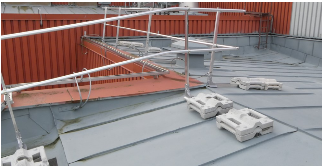
Kuva 41. Vesikatolle asennettu vastapainokaide.
