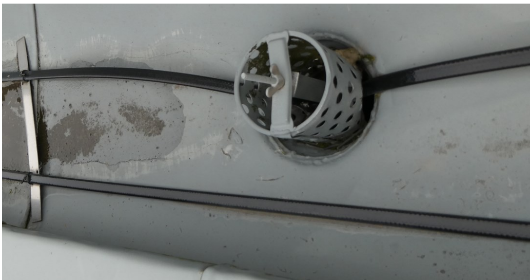
Kuva 25. Vesikourun pohjassa oleva vedenpoistokaivo.
