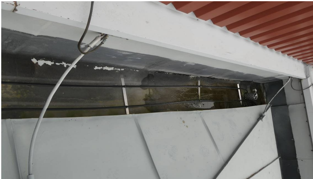
Kuva 24. Sisäpuolinen vesikouru bitumisella pinnoituksella.
