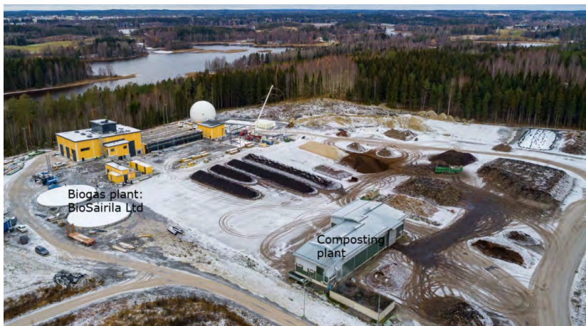
KUVA 2. BioSairilan biokaasulaitos ja sen rinnalla toimiva kompostointilaitos (kuva Metsäsairila Oy).
