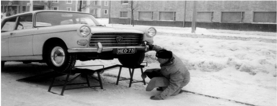
Kuva 1. Peugeot 404 katsastus kadunvarressa. Auton etupää nostettu, jotta katsastaja voi tarkastaa alustaa helpommin. (A-Katsastus 2022.)
