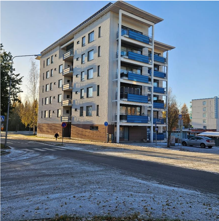
Kuvio 24. Julkisivunäkymää Kypäräkatu 5 Kuopio (Valokuva 2 Kypäräkatu 5)
