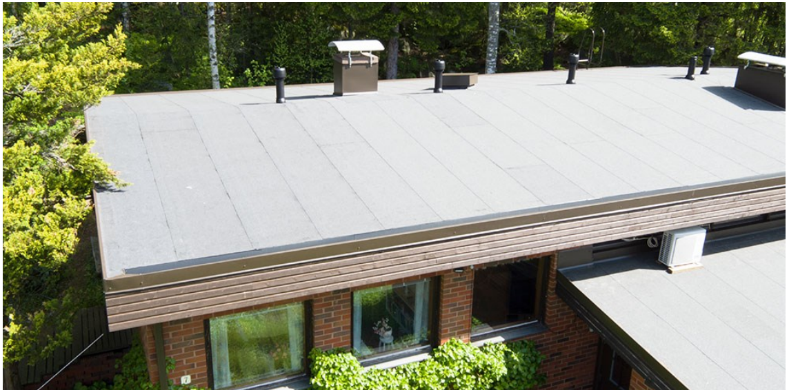
Kuvio 1. Kuviossa näkyy piilokoururakennetta ja syöksytorvi lähtee alas rakenteesta (Kattoremontti).
