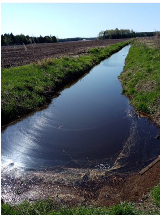
Kuva 99. Avo-ojaan padottunutta vettä.
