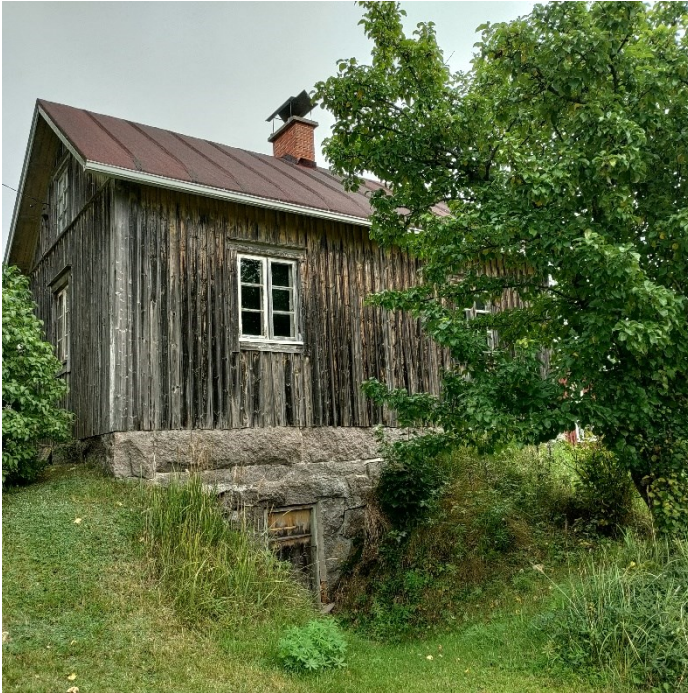
Kuva 4. Etelän puoleinen seinä.
