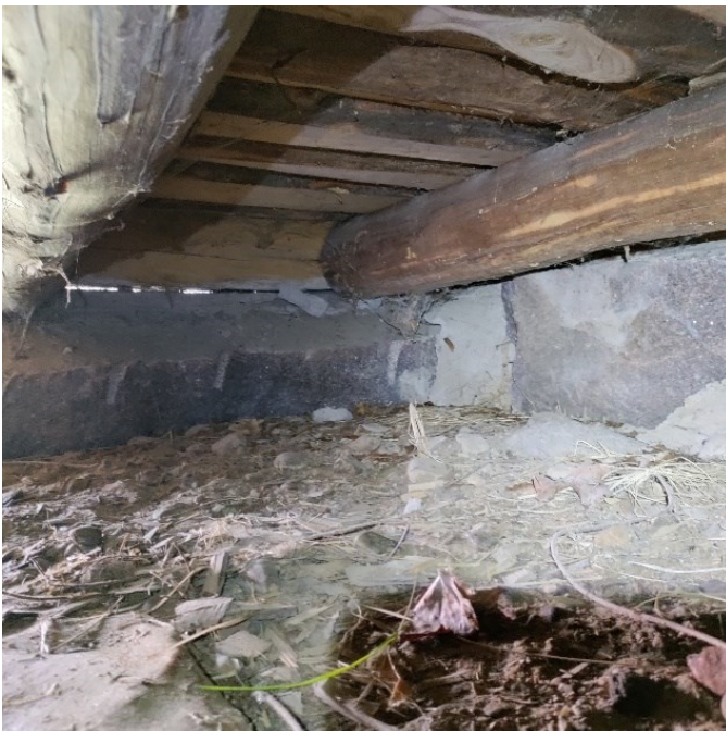
Kuva 5. Tuulettuva alapohja.
