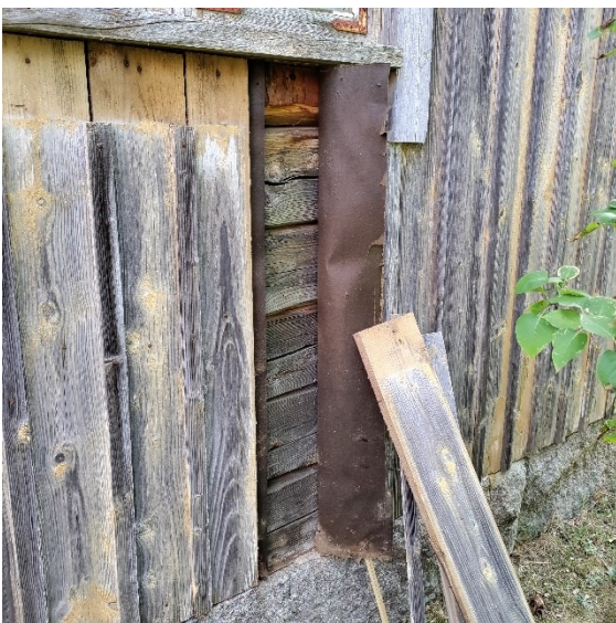
Kuva 6. Seinän rakenne ulkoa.
