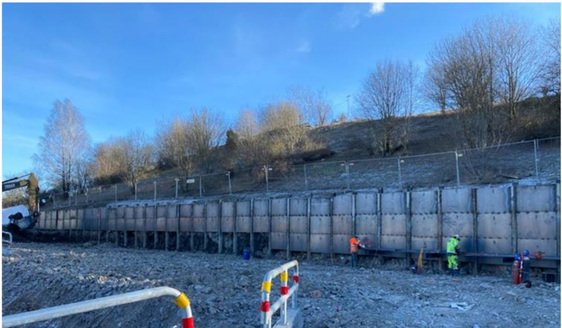
Kuva 12. Työnaikaisen kaivannon tuennassa käytetty porapaalusettiseinä vuonna 2021.
