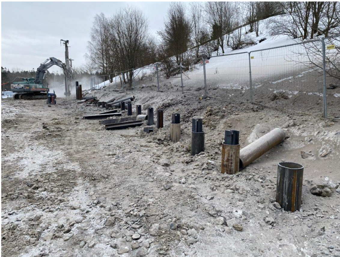
Kuva 15. Porapaalusetteisän porapaalut asennettuna.
