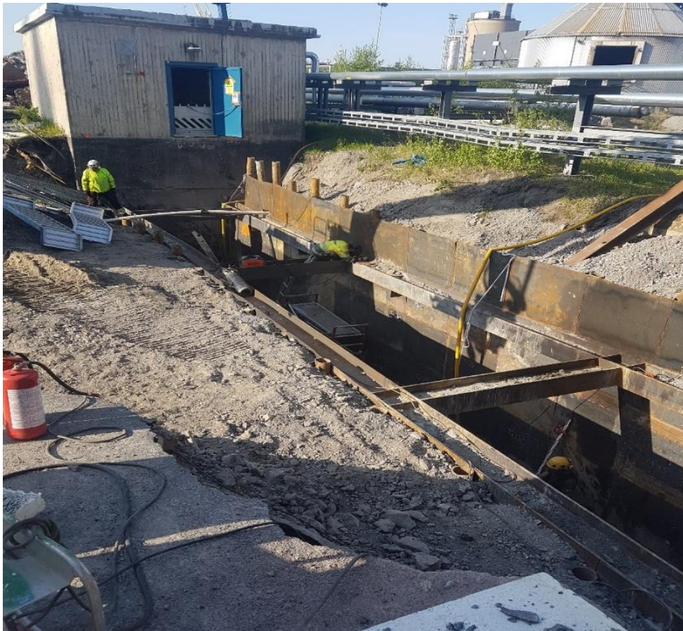
Kuva 11. Vaskiluodon voimalaitokselle rakennettu porapaalusetteisinä vuonna 2023.
