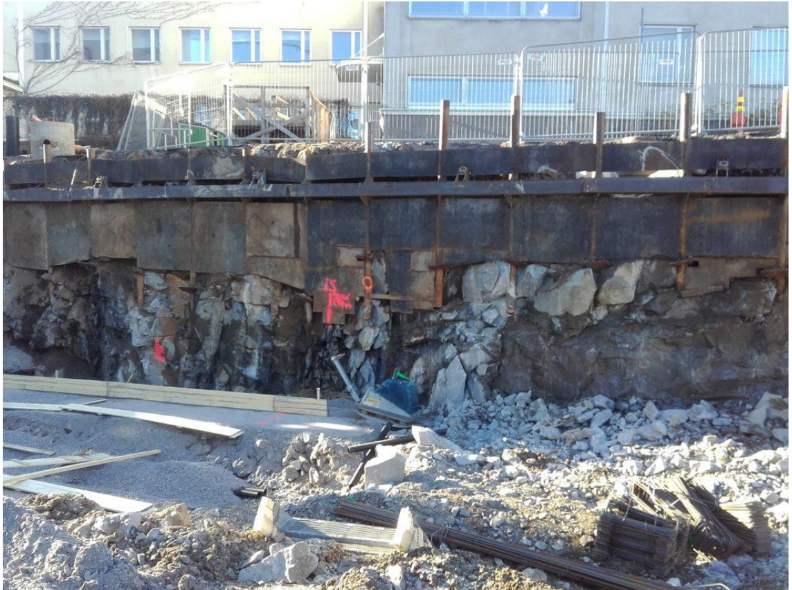
Kuva 17. Turussa toteutettu porapaalusetseinä.
