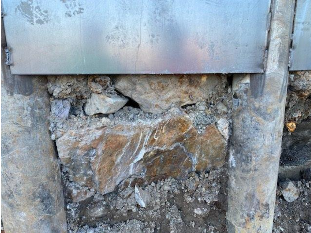
Kuva 14. Suuri lohkare porapaalujen välissä.
