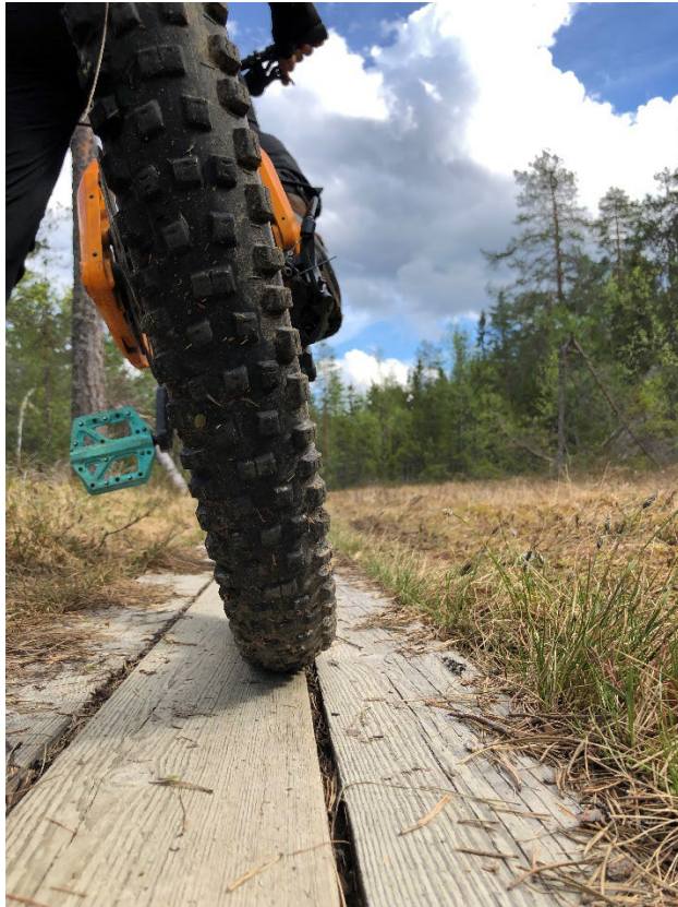
Kuva 4. Pitkospuut tuovat reitille haasteita ja niiden rakentamisessa on otettava pyöräilijä huomioon. Kuva: Pasi Korhonen.
