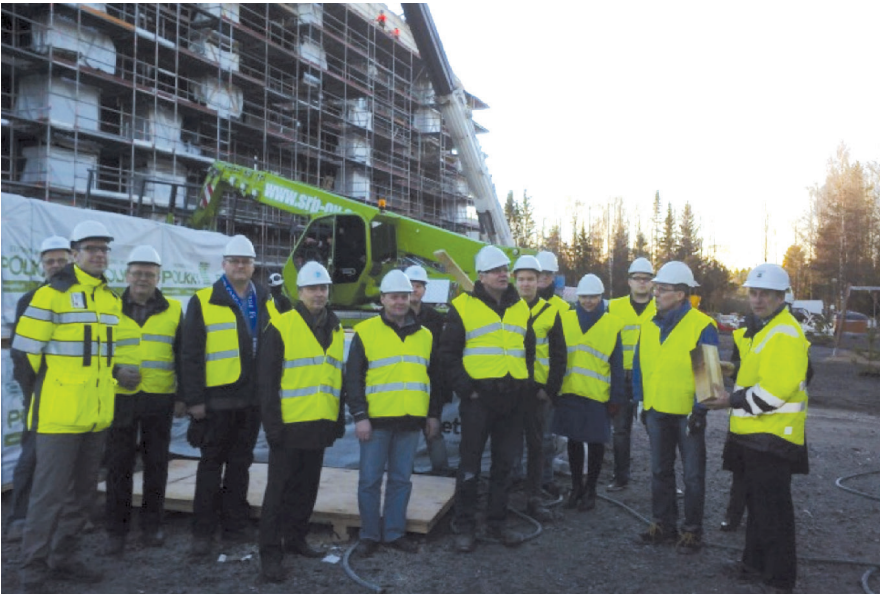
KUVA 1. Puu-Hubin Tilaelementti -koulutuksessa käytiin tutustumassa Suomen ensimmäisen CLT-tilaelementtitekniikalla rakennettavan kerrostalon työmaahan (Lintuviita 2, Seinäjoki). (Kuva: Tuulia Taanila).
