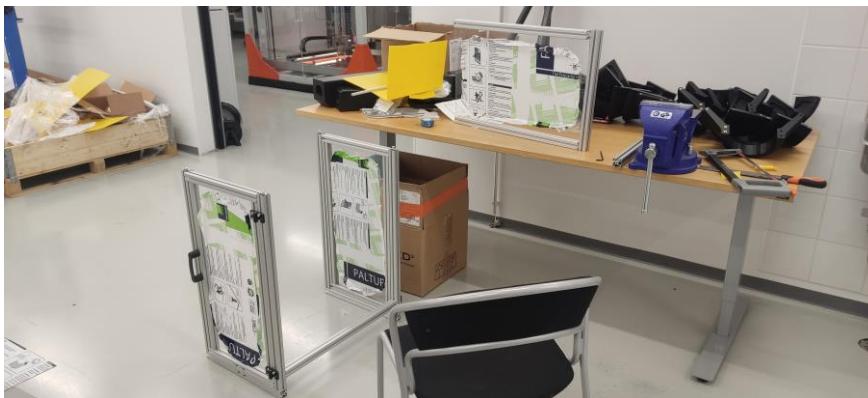
Kuva 65. Levyjen asennus suojan runkoon.
