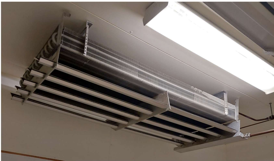
Kuva 9. Luonnollisen ilmankierron höyrystin.
