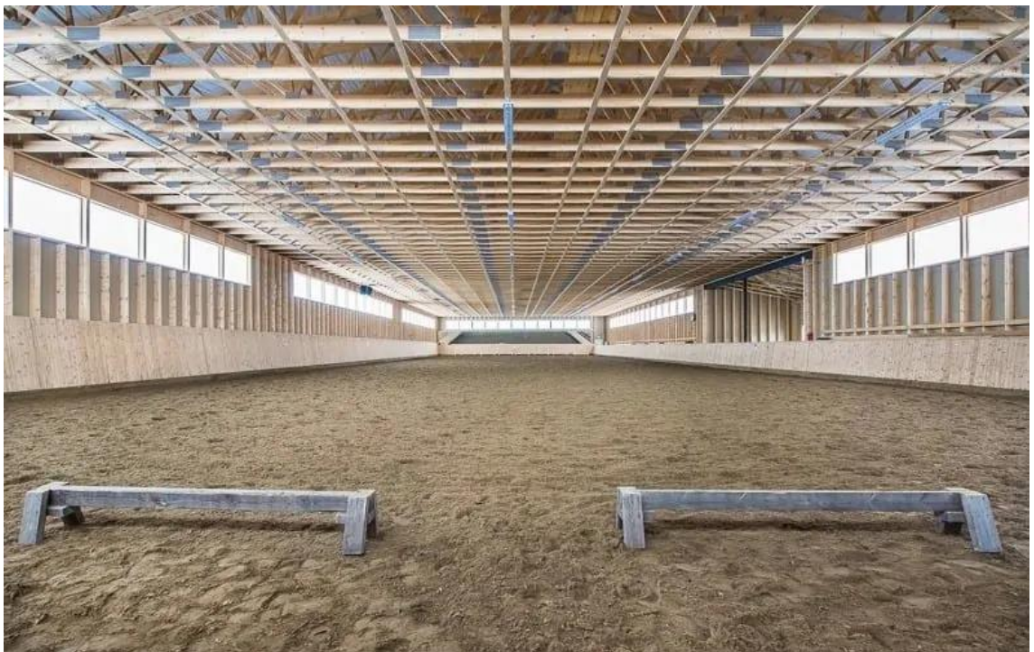
Kuva 1. Maneesirakennus Orimattila Orivet Oy [1]
