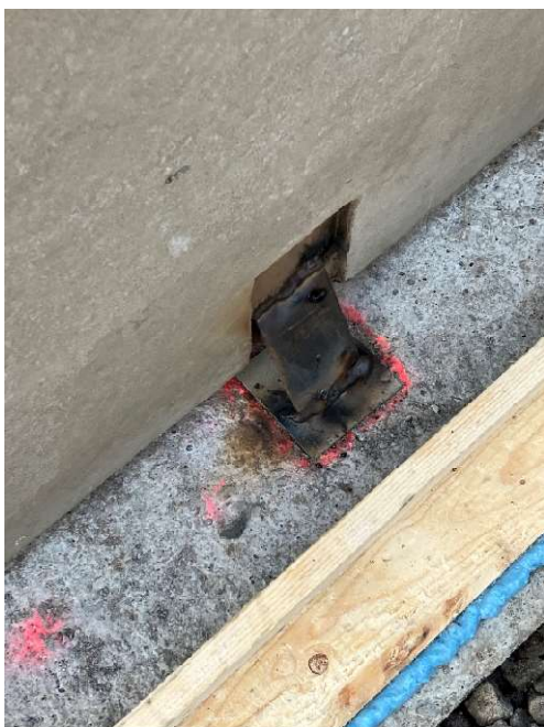
Kuva 3. Betonielementin hitsausliitos, (Rintamäki 2023)
