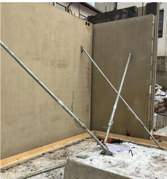
Kuva 4. Betonielementti tuettuna, (Rintamäki 2023)
