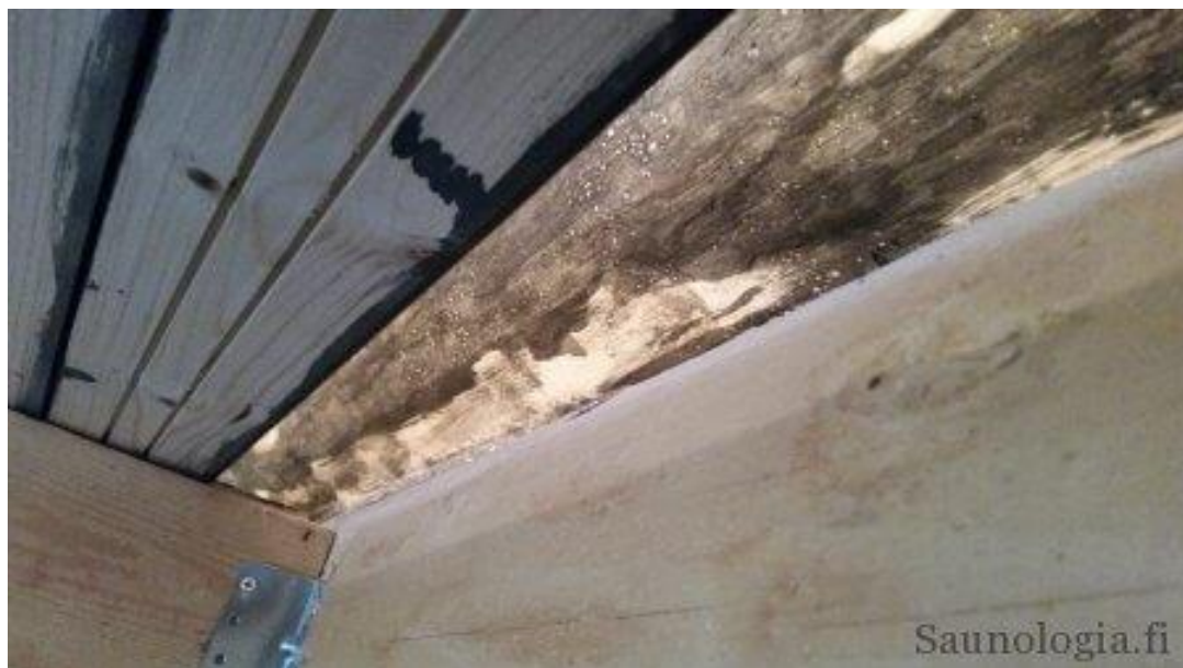
Kuva 9. Saunan lattiaautojen ja seinän väliin jätetty tuuletusrako. (Liikkanen 2019)
