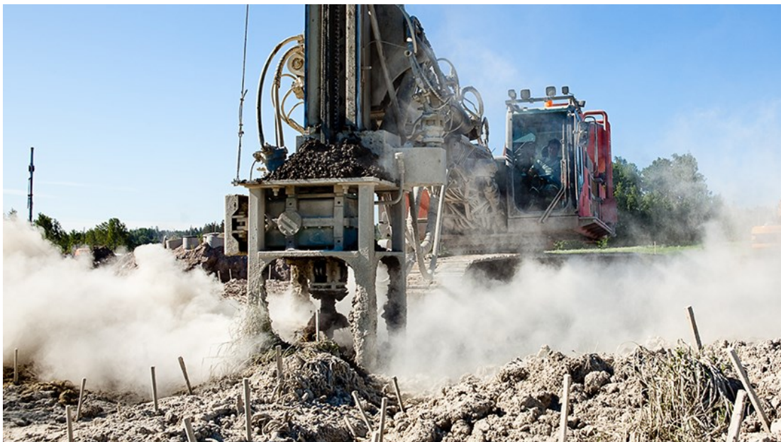
Kuva 2. Pilaristabilointia (YIT pilaristabilointi)
