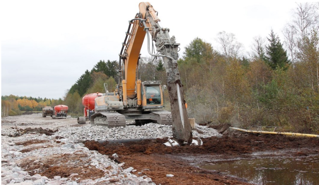
Kuva 4. YIT massastabilointikone tositoimissa. Stabiloidaan lamelli kerrallaan, kaivinkone ja sideainevaunu liikkuvat eteenpäin sitä mukaa, kun lamellit saadaan
