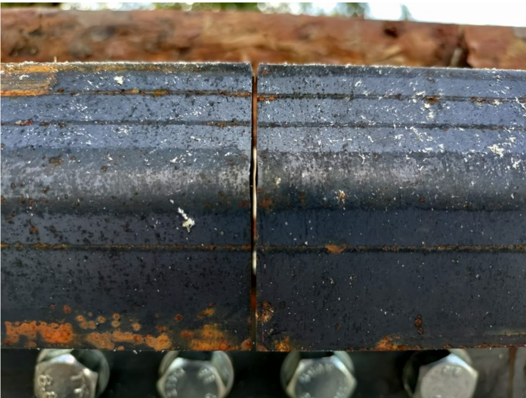
Kuva 57. Rako pitkittäisten runkoprofiilien välillä
