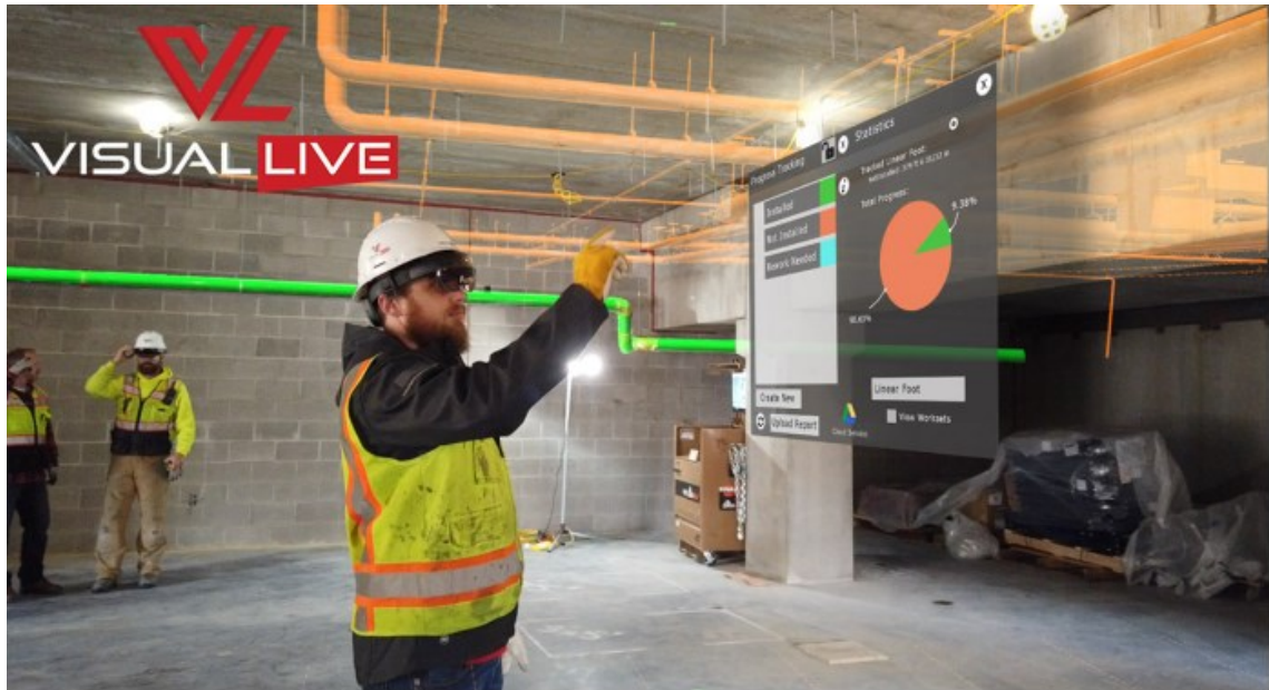
Kuva 17. Virtuaalitekniologia mahdollistaa visuaalisuuden lisäksi rakennuksen tietojen tarkastelun MR-lasien avulla (VisualLive).
