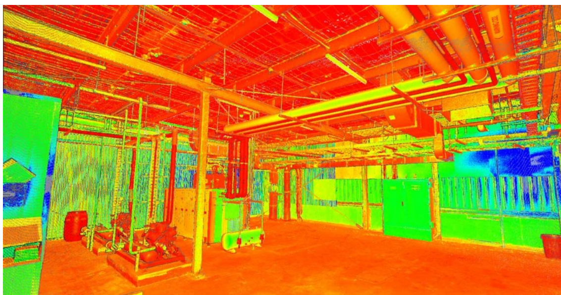
Kuva 9. Pistepilvestä saadaan luotua tarkka 3D-malli rakennuksesta.
