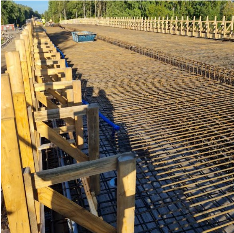
Kuva 6. S106 valmis raudoitus
