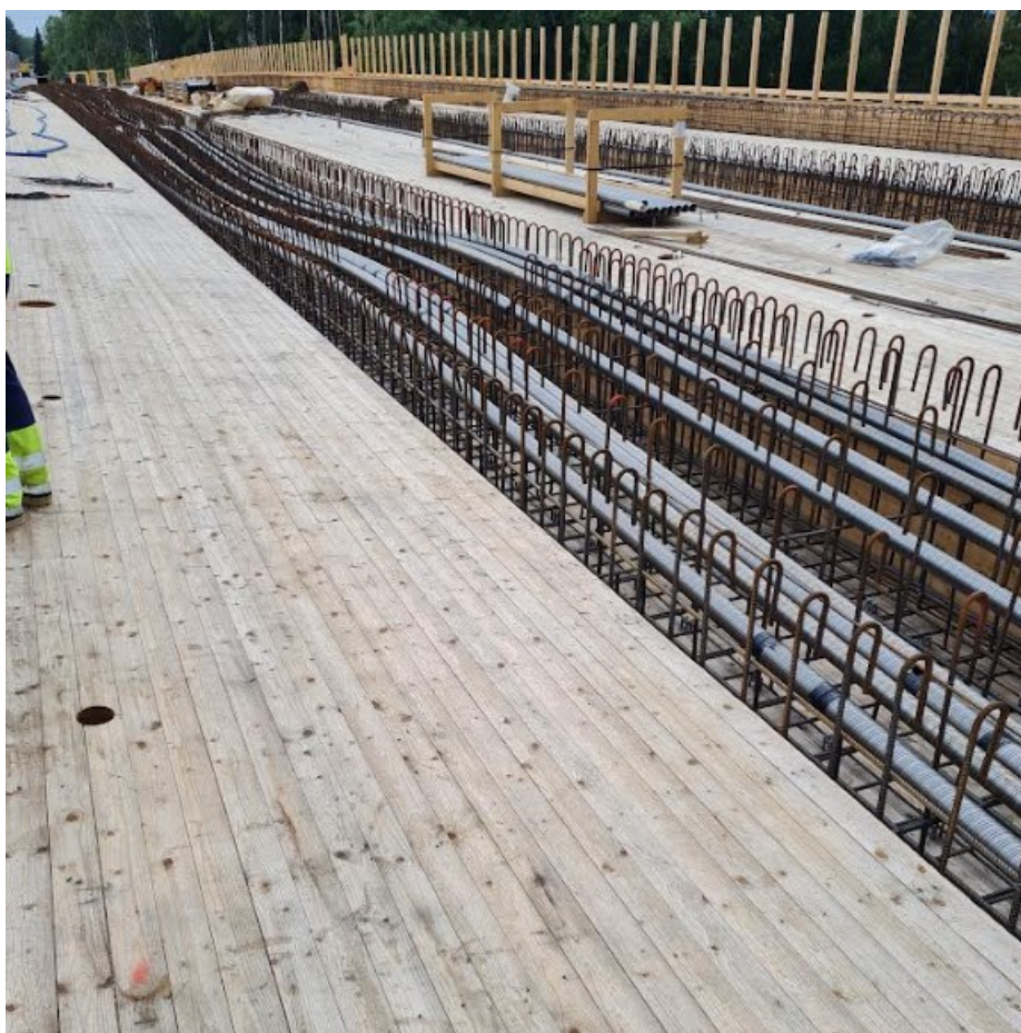
Kuva 9. S106 jänneterästen suoja-putket
