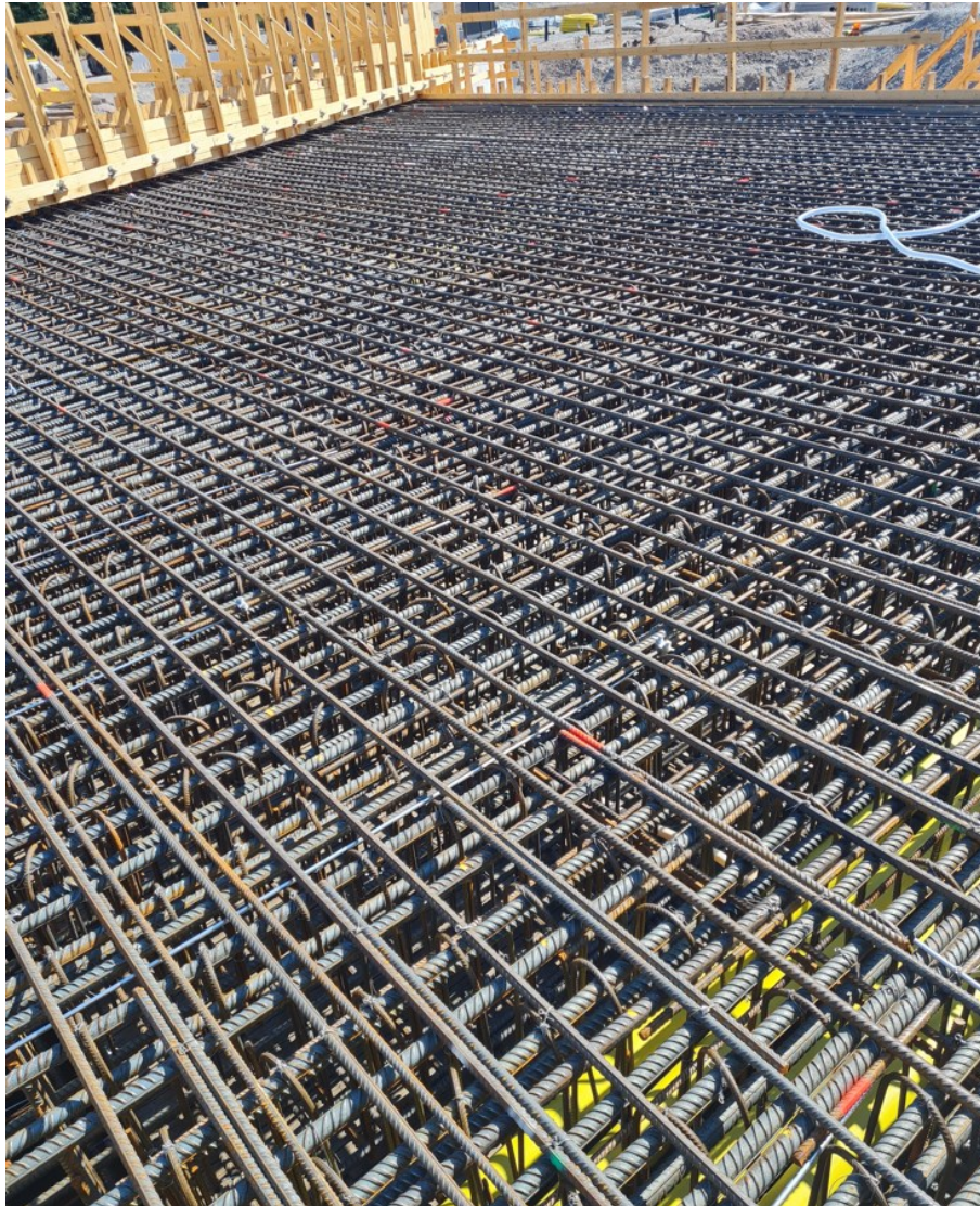
Kuva 7. S101 kehäsillan valmis raudoitus
