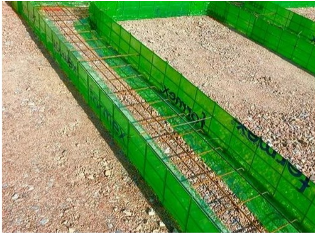
Kuva 3. Yksinkertainen Formex anturamuotti (Netrauta s.a.)
