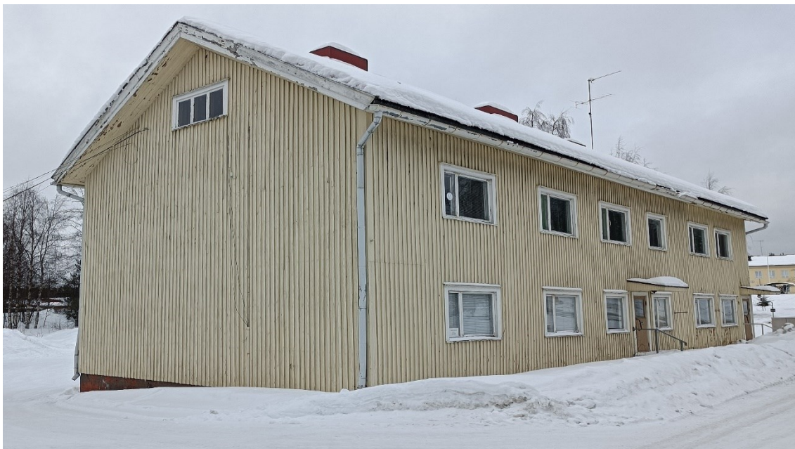
Kuva 2. Purkukohde kuvattuna Syrjäkadun puolelta.
