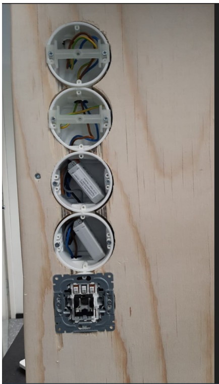
Kuva 40. Opetuslaitteiston ohjainlaiteasennus kojerasiaan.
