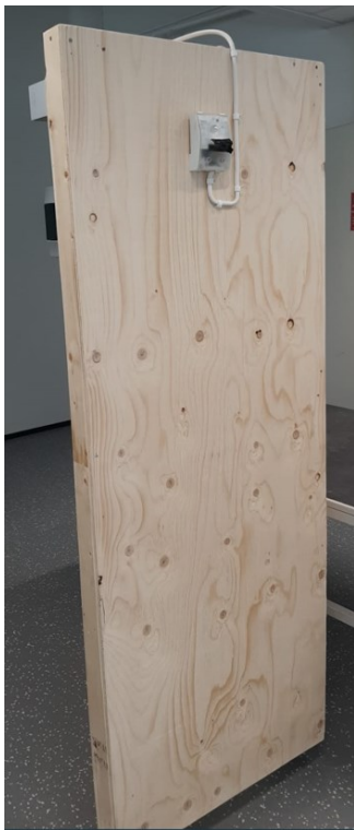
Kuva 39. Opetuslaitteiston hämärekytkinasennus takaseinällä.
