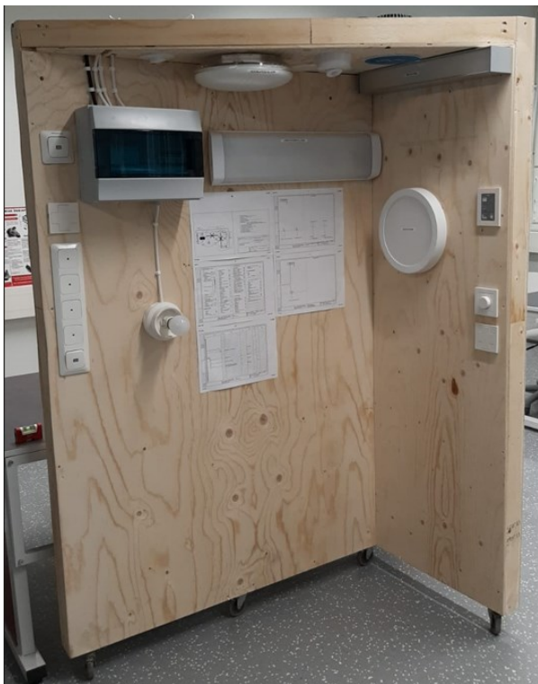
Kuva 38. Valmis DALI-valaistusohjausjärjestelmän opetuslaitteisto.
