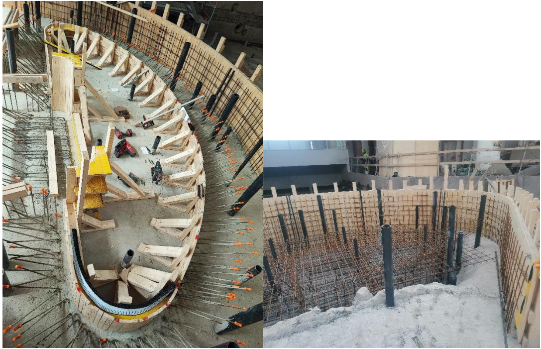
Kuva 11 Pystyrakenteiset, kaarevat kappaletavaramuotit kuvattuna Aalto Alvarin työmaalla Jyväskylässä 2022
