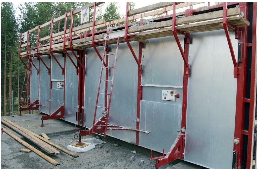
Kuva 12. Lämmitysjärjestelmällä varustettu suurmuotti (Sunicon 2023)
