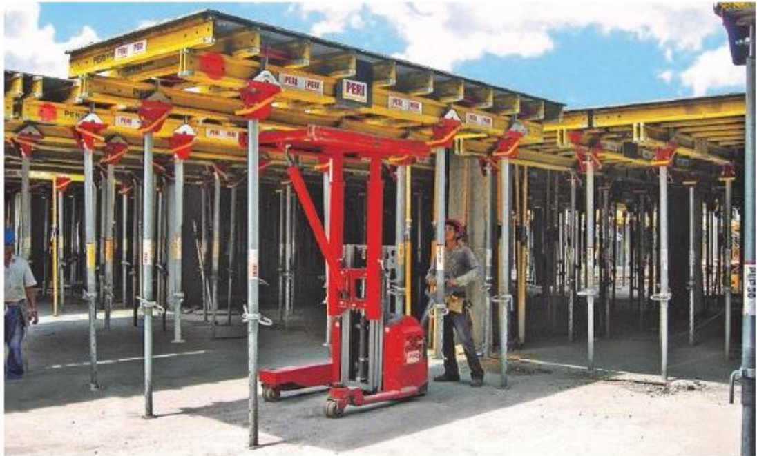
Kuva 9. Pöytämuotti työmaalla (PERI Suomi Ltd Oy 2009)
