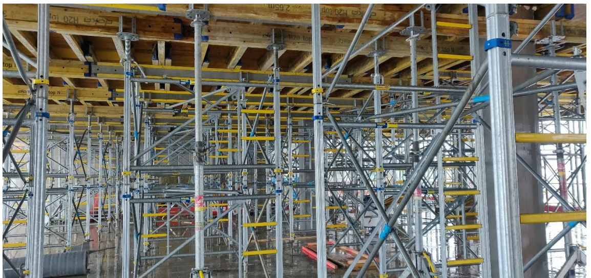
Kuva 6. Vakiopalkkijärjestelmä työmaakäytössä
