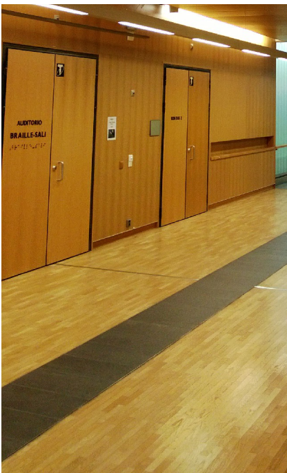
Kuva 10. Ovien kontrastilistat ja käytävän suuntaa ohjaava lattiaopaste väri- ja materiaalivalinnoiltaan homogeenisessa ympäristössä (Iiris-keskus, Helsinki)
