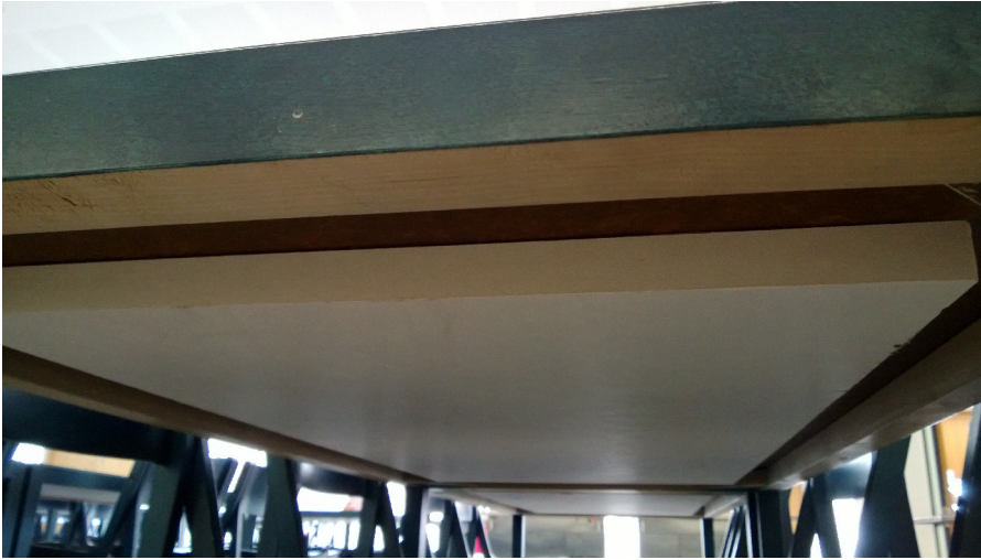
Kuva 18. Akustoiva levy ruokapöydän alapinnassa (Iiris-keskus, Helsinki)
