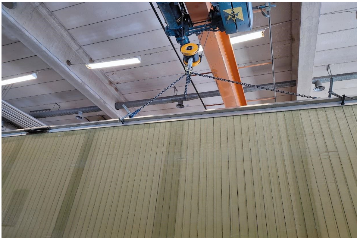
Kuva 9. Yläprofiilin asennus nosturin avulla paikalleen. Profiiliin on kiinnitetty liimapuristimet, jotka on yhdistetty ketjulla nosturiin. Jotta pitkä profiili saadaan nostettua tasaisesti ylös, on sen tasapainotus tarkkaa. Tasapainotus toteutetaan ketjun pituutta muuttamalla. (Tomi Jetsonen, 2023, CC BY).
