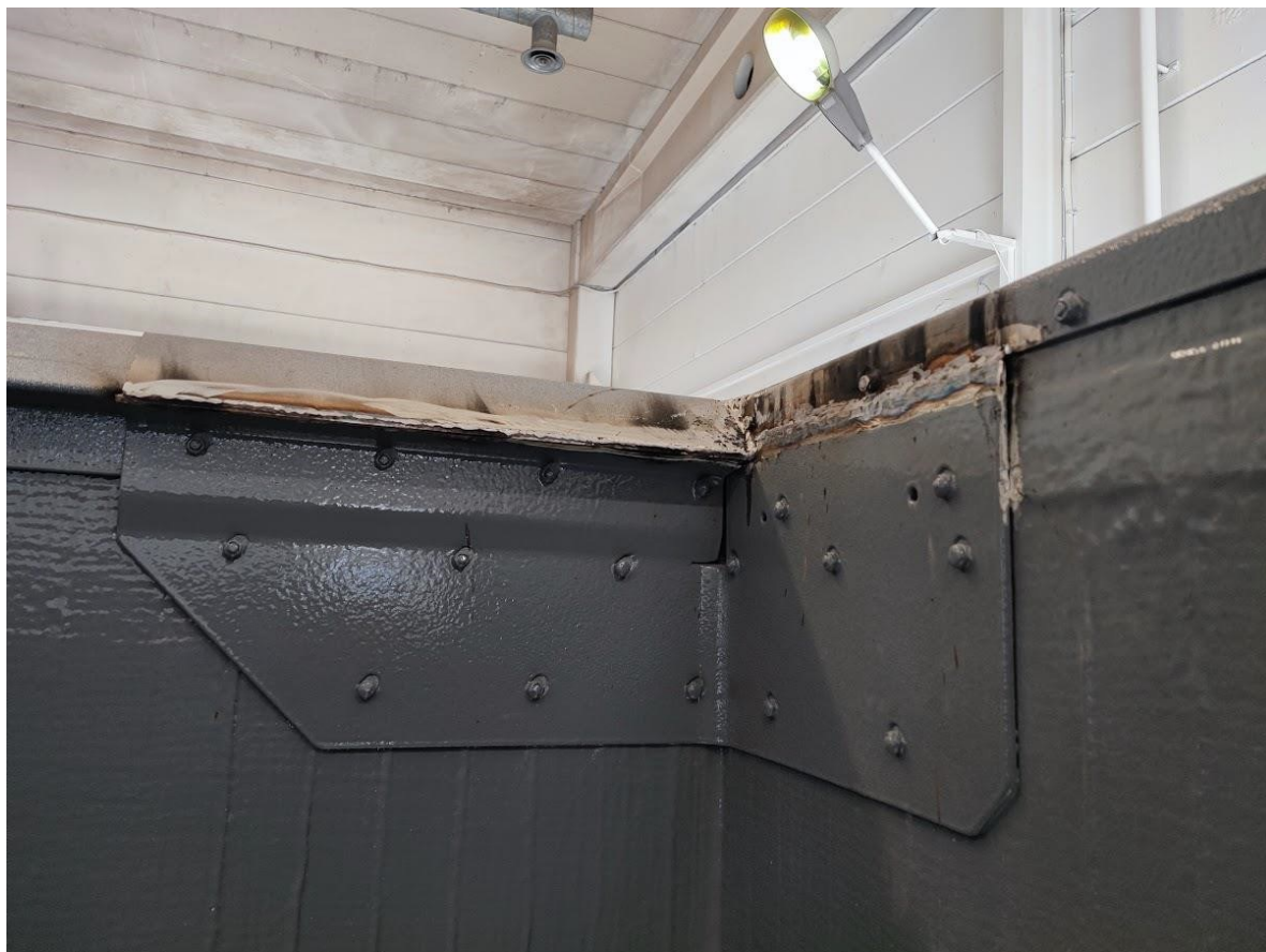
Kuva 13. Maalattuja ja pinnoitettuja osia hitsattu. (Tomi Jetsonen, 2023, CC BY).
