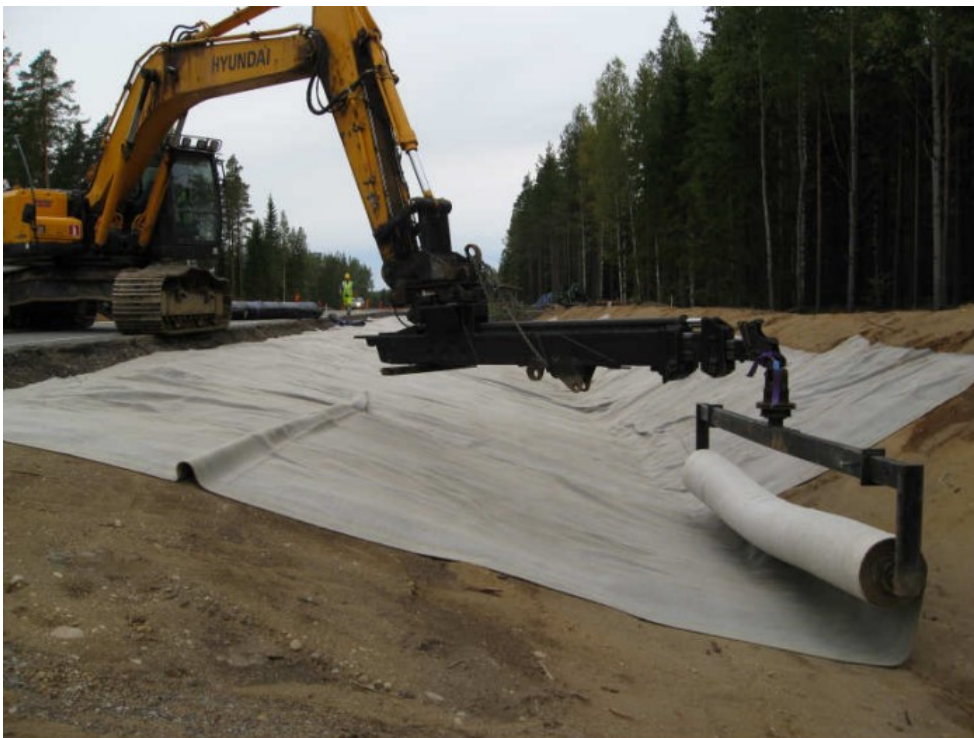
Kuva 3. Bentoniittimaton asentaminen ojaan (Horn 2008).
