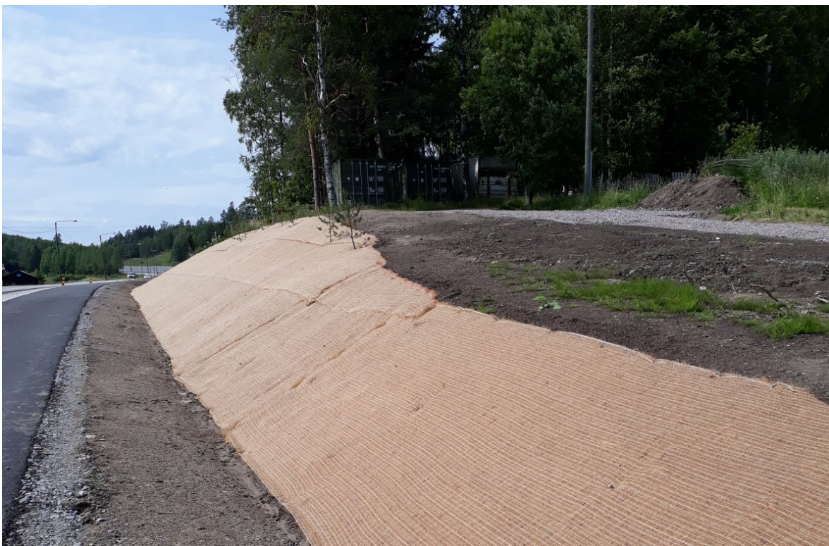
Kuva 4. Eroosiomaton käyttö luiskassa (Rakennusfakta 2021n).
