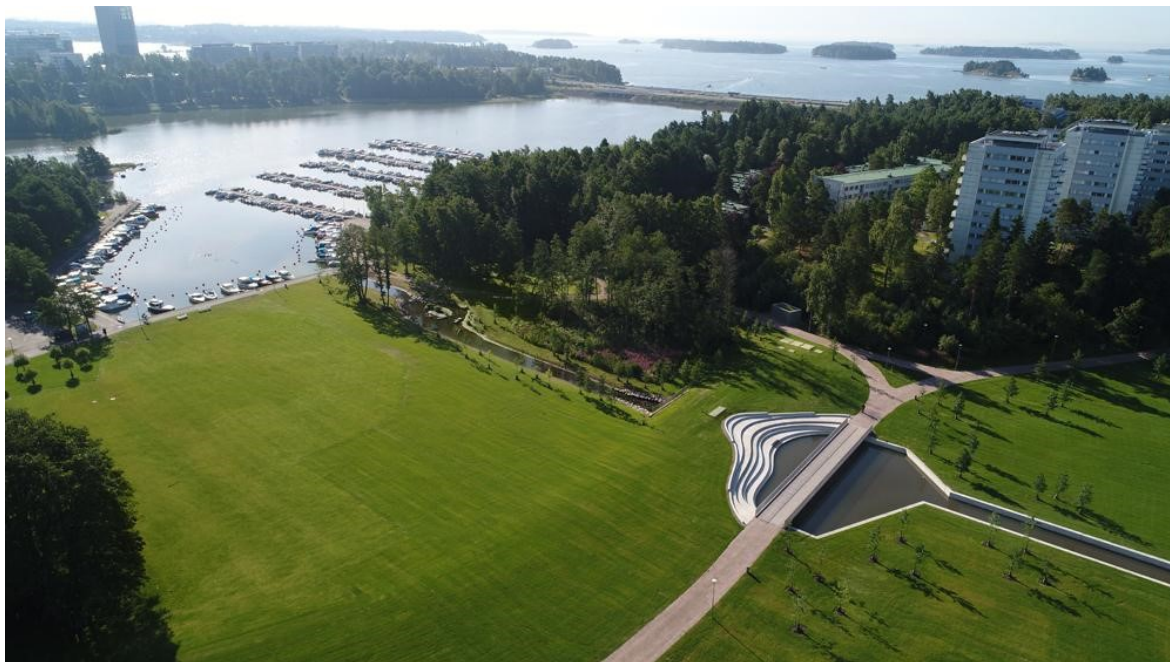
Kuva 8. Leimuniityn korotettu niitty ja hulevesiallas (Betoniteollisuus Ry 2023).
