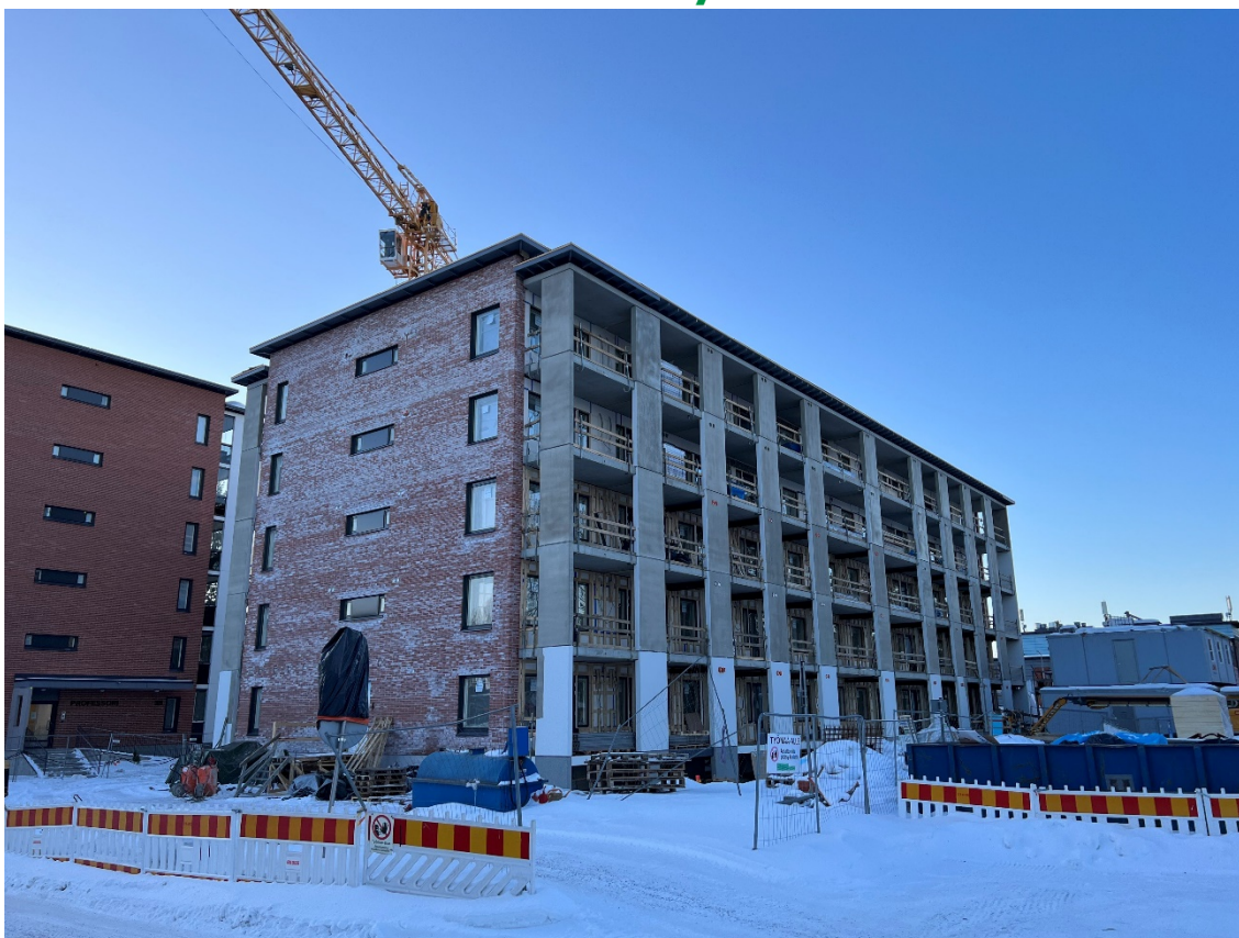
Kuva 1. As. Oy Dosentin työmaa, maaliskuu 2023. Kuva: Juuso Kokkonen.
