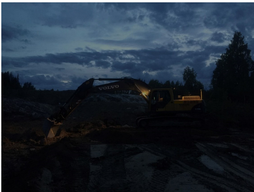
Kuva 7. Kaivinkoneet pystyvät työskentelemään koneohjauksen avulla myös yöllä
