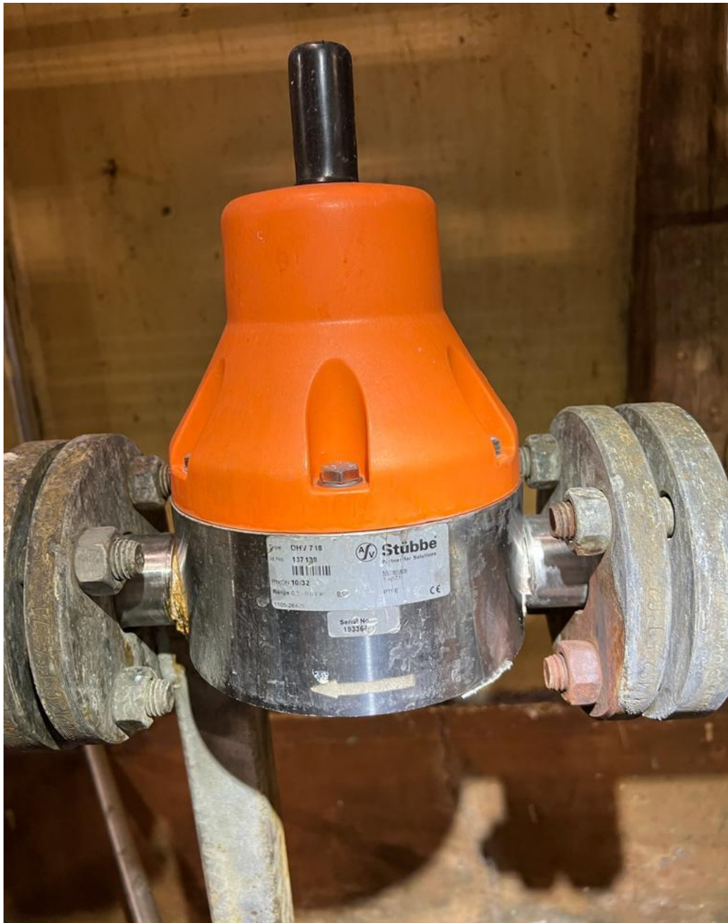
Kuva 4. Varoventtiili Stübbe askorbiinihappolinjassa Jervois Finland -yrityksessä
