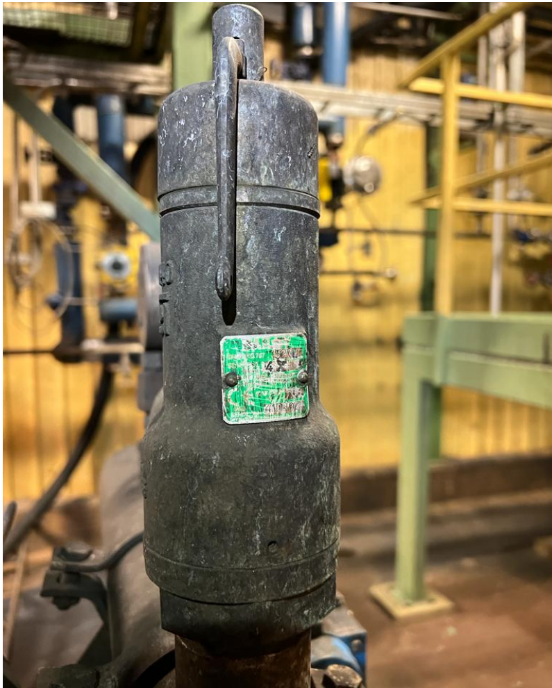
Kuva 9. Varoventtiili Bailey Jervois Finland -yrityksessä.
