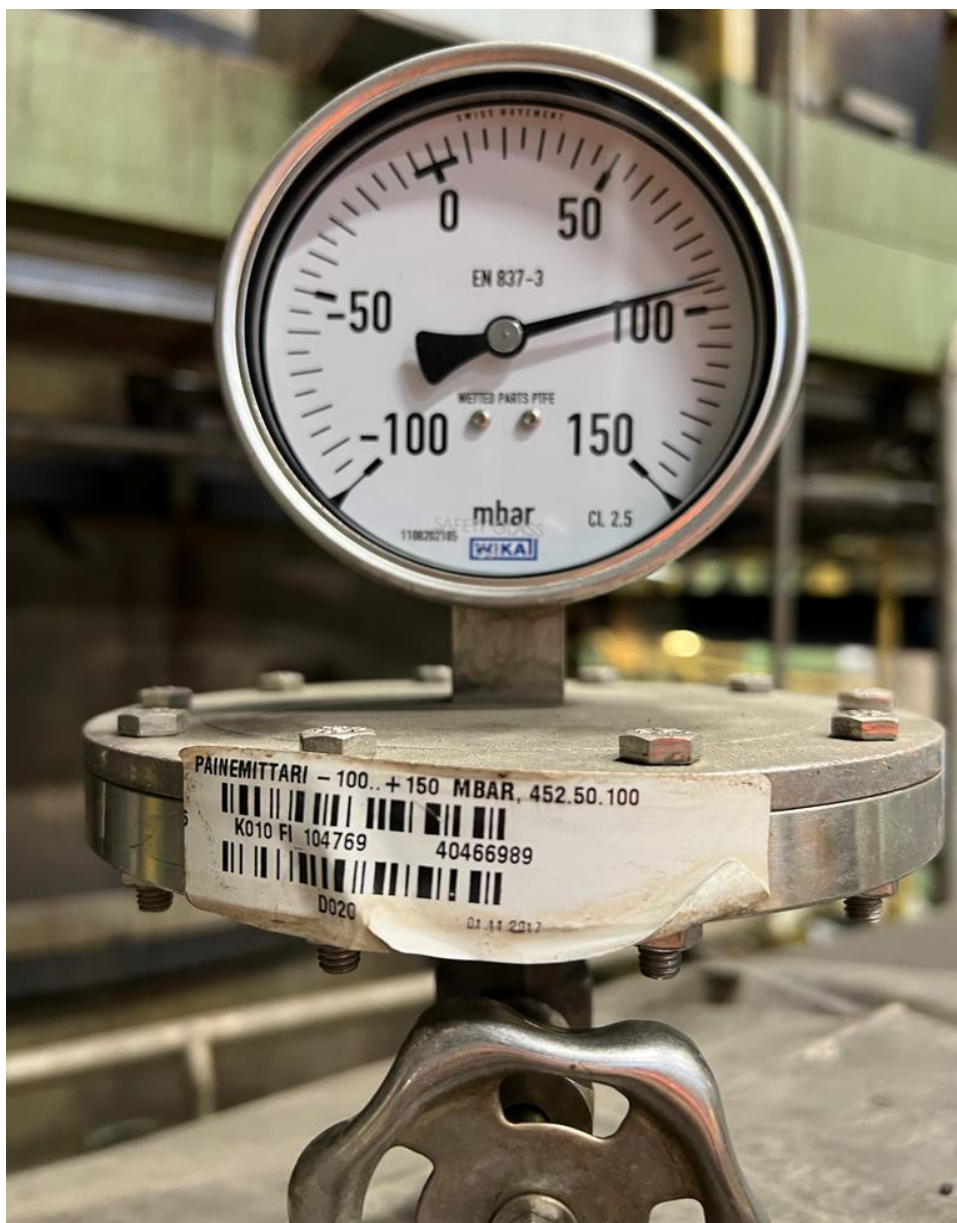
Kuva 17. Kalvollinen painemittari Jervois Finland -yrityksessä.
