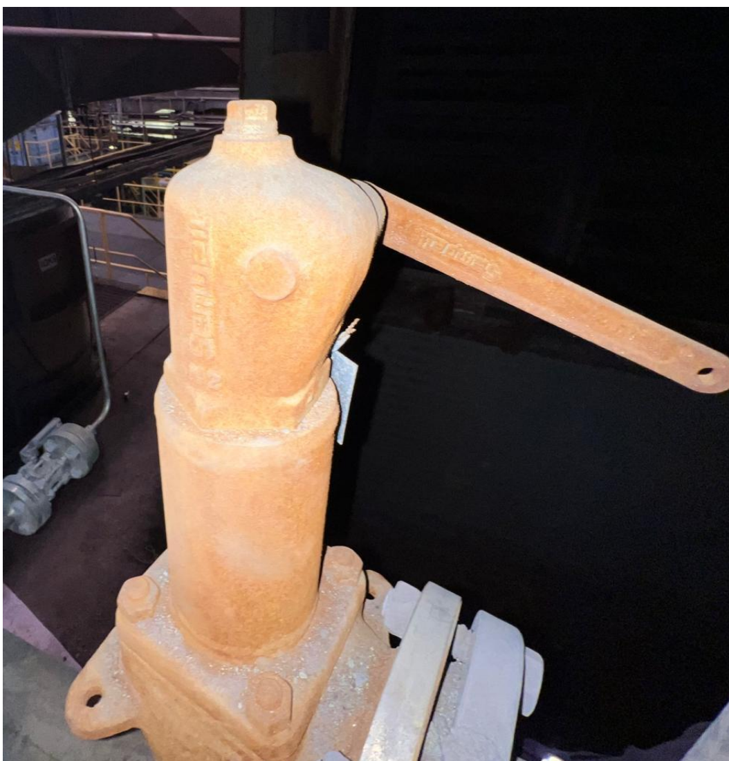
Kuva 11. Hiilidioksidilinjan varoventtiili Jervois Finland -yrityksessä.
