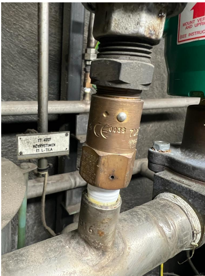
Kuva 6. Varoventtiili Rego propaanilinjassa Jervois Finland -yrityksessä.
