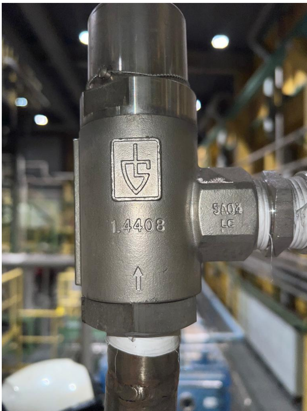
Kuva 8. Varoventtiili Goetze.
