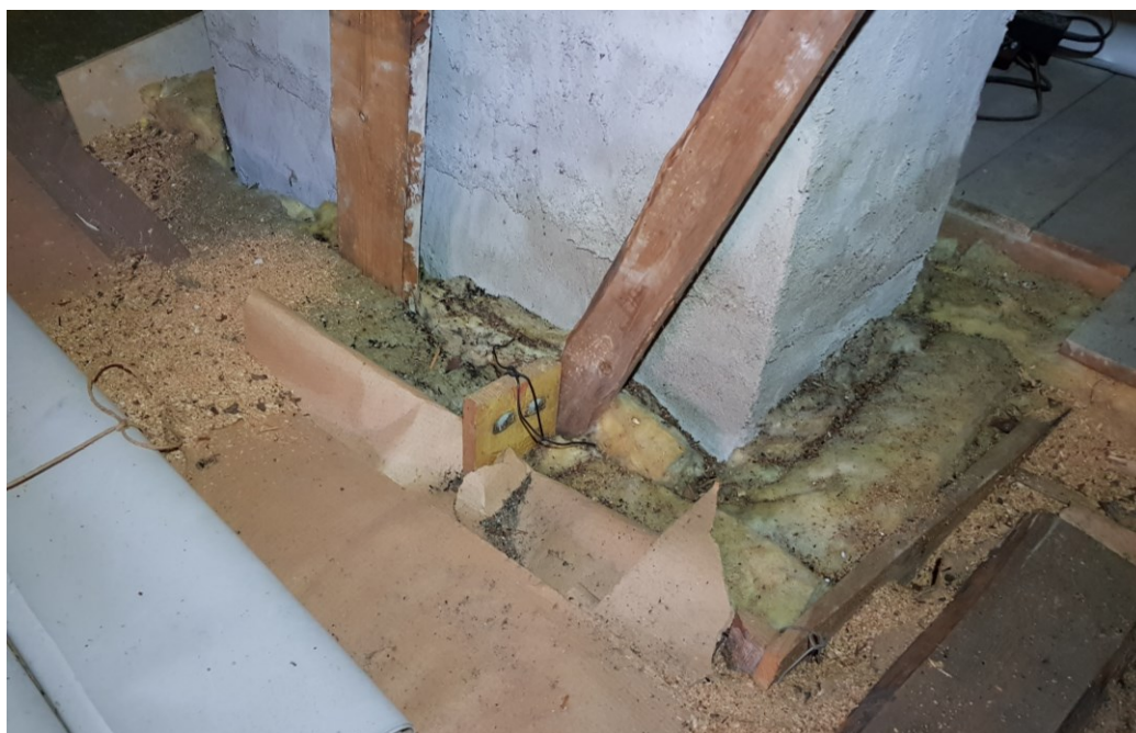
KUVA 18. Hormin läpivienti yläpohjassa
