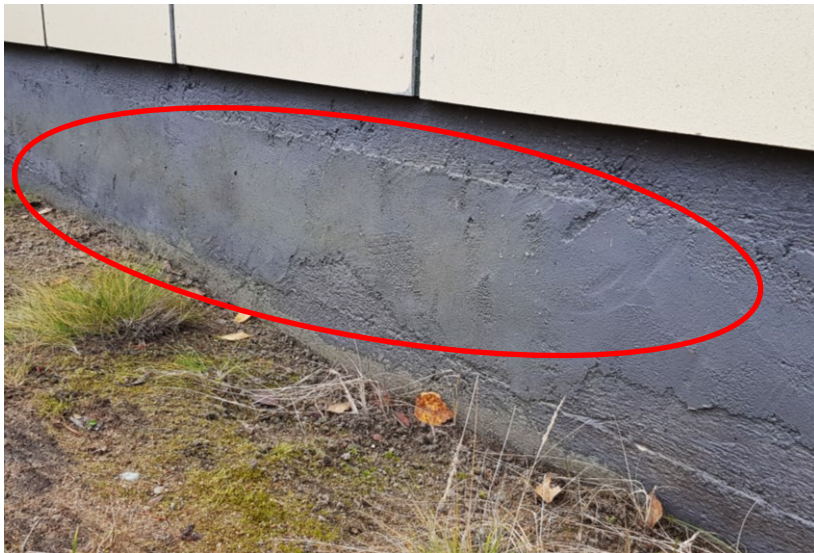
KUVA 14. Pohjoisenpuolensokkelin pinta on vihertynyt
