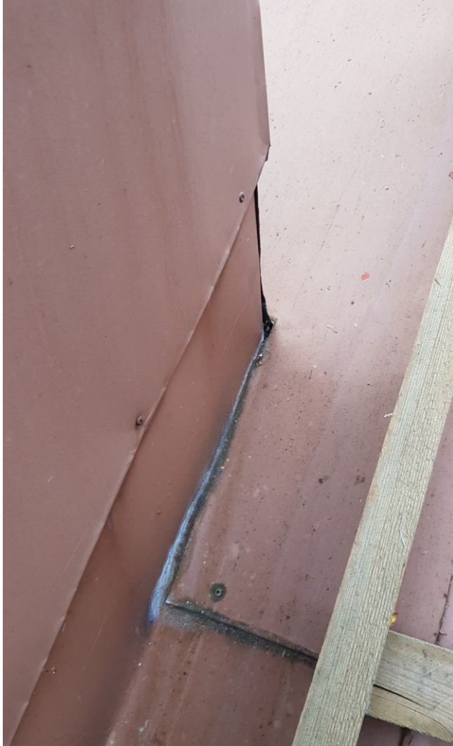
KUVA 29. Savupiipun liitoskohta
