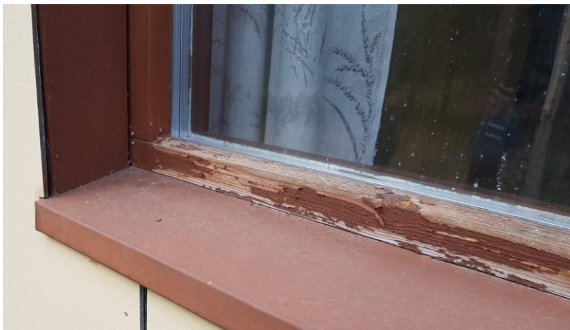
KUVA 4. Ikkunan ulkopuutteesta hilseillyt maalia
