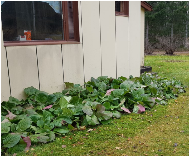
KUVA 15. Istutukset kiinni perusmuurissa talon länsipuolella
