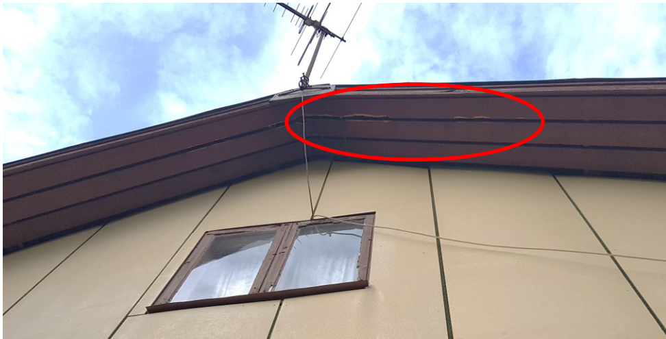
KUVA 10. Tikan tekemät reiät itäpuolen räystääslaudoituksessa merkitty punaisella
