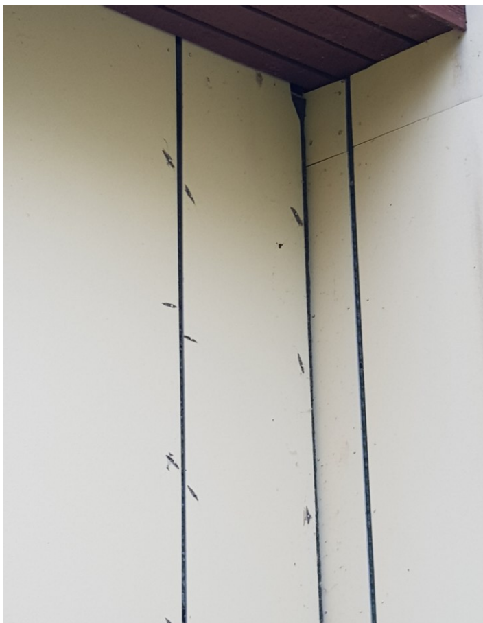
KUVA 22. Vaurioita kuitusementtilevyssä
