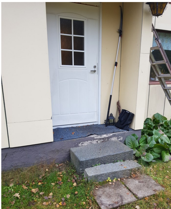
KUVA 30. Sisäänkäynti ja ulko-ovi
