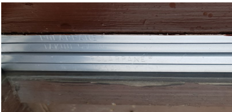
KUVA 33. Takuutiedot lämpölasielementti-ikkunassa
