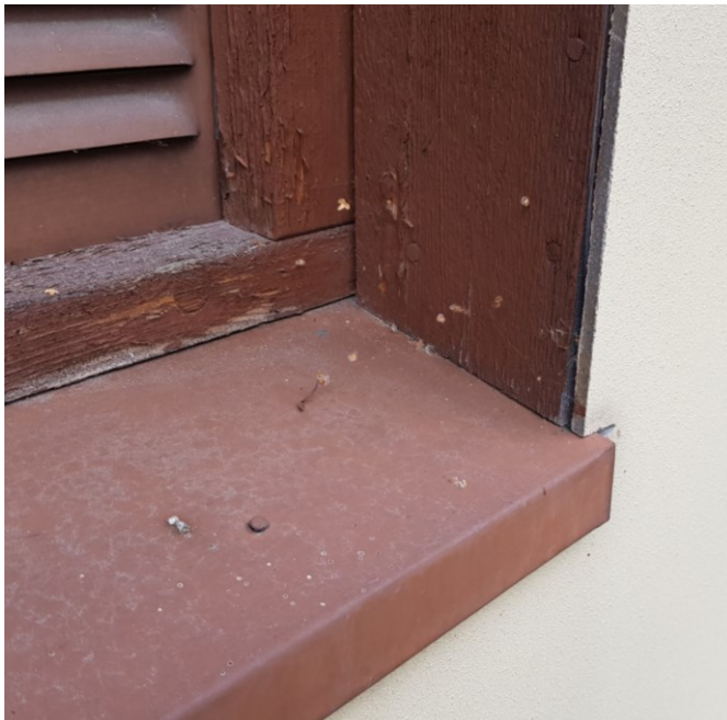
KUVA 34. Ikkunapelti smyygin alla
