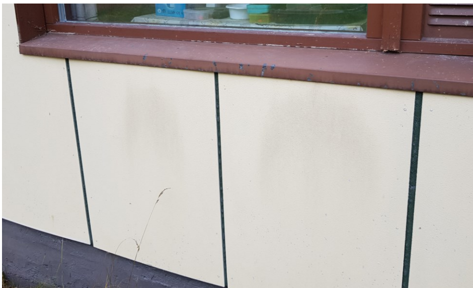
KUVA 21. Värjäymää kuitusementtilevyssä ikkunan alla
