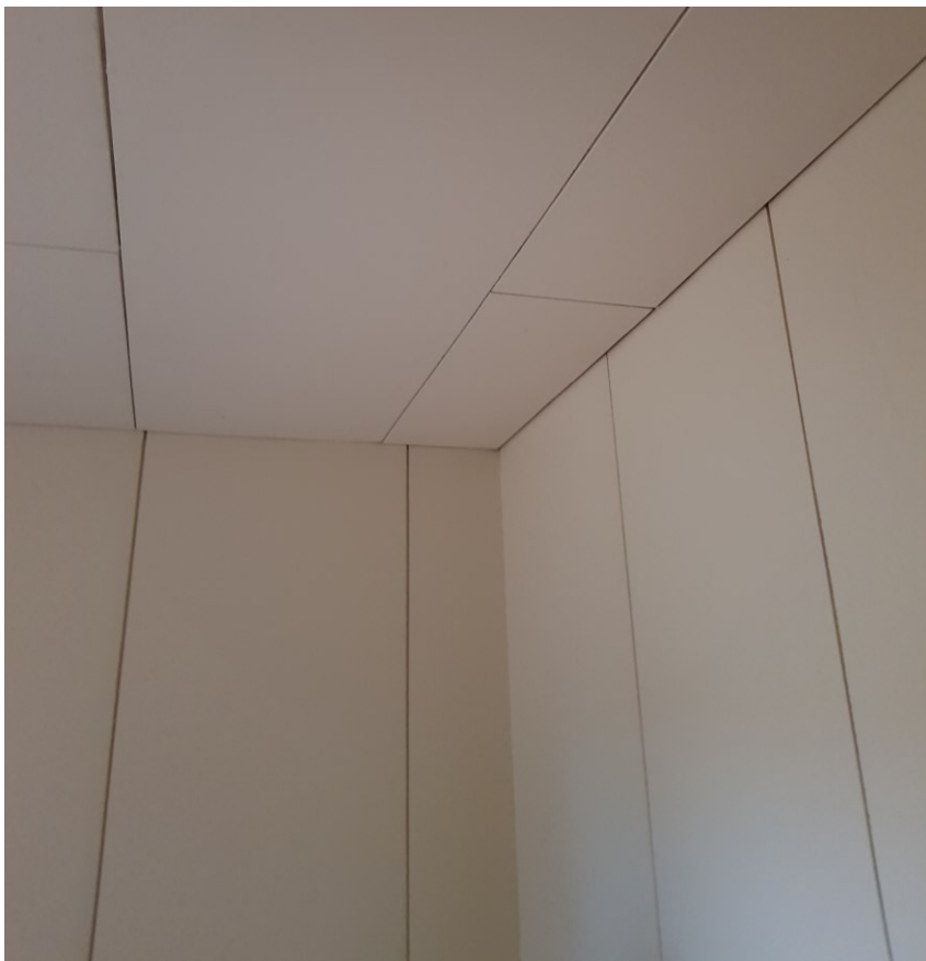
KUVA 37. Laajennusosan väliseinää ja kattoa
