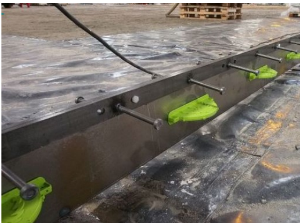
Figur 20. Terajoint dilatationsfog. (Peikko Oy, 2023).
