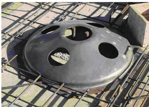
Figur 18. UFO-genomstansningsförstärkning i bjälklag innan gjutning. (Celsa, 2022, s.1).
