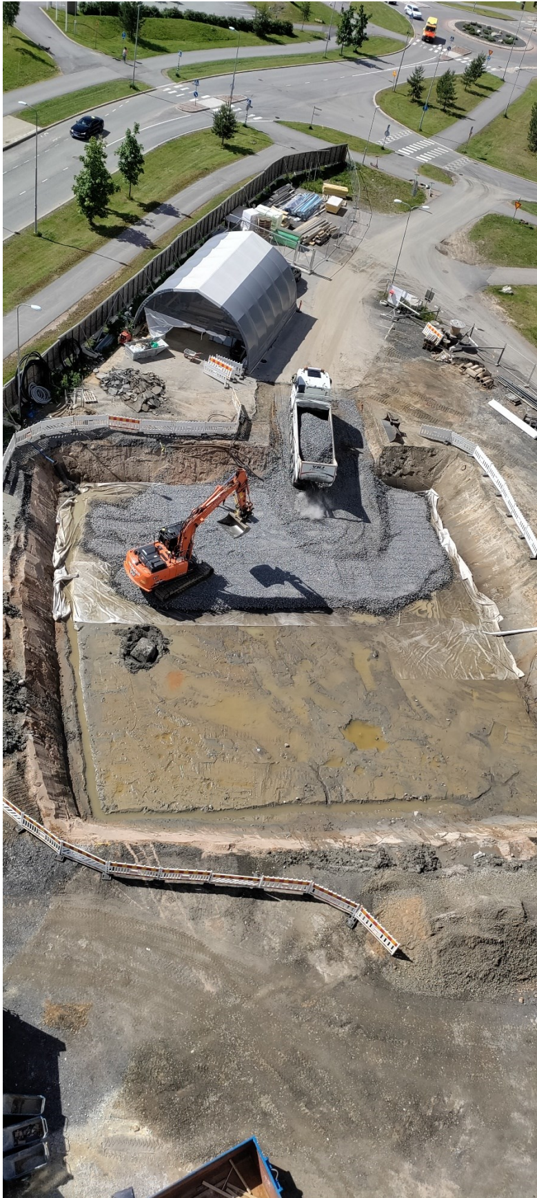
Kuvio 3. Viereisen työmaan massanvaihdot lähes tehty (Vilppola 2022c)
