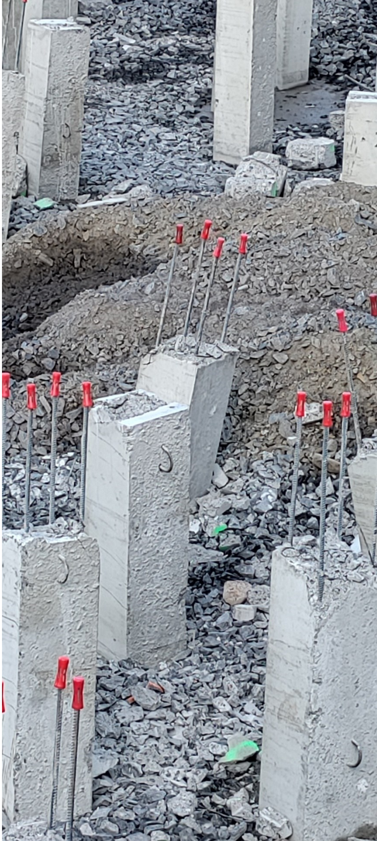
Kuvio 4. Paalut katkottu määrämittaansa (Vilppola 2022d)
