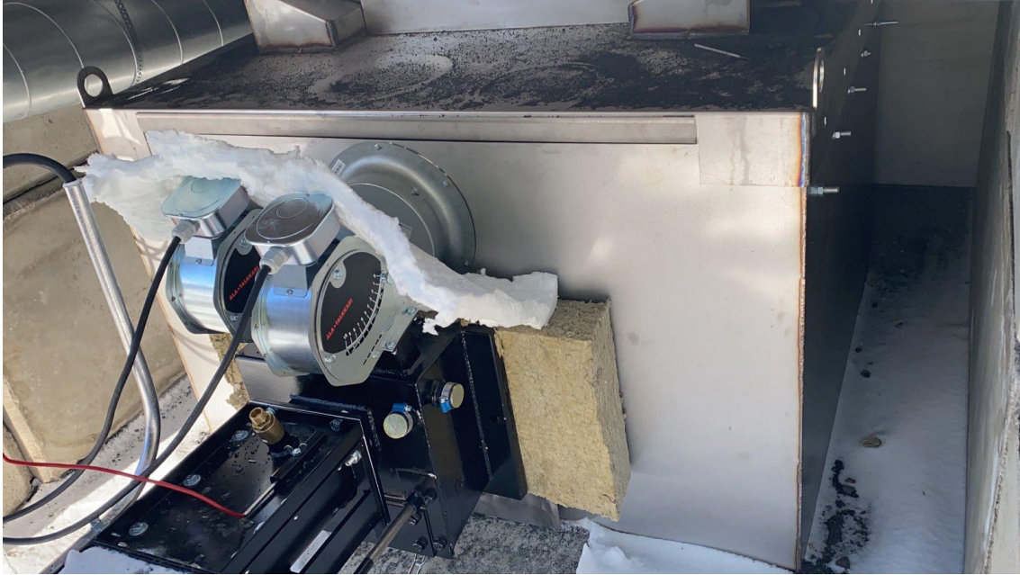
KUVA 19 Polttimen asennus polttopesään.
