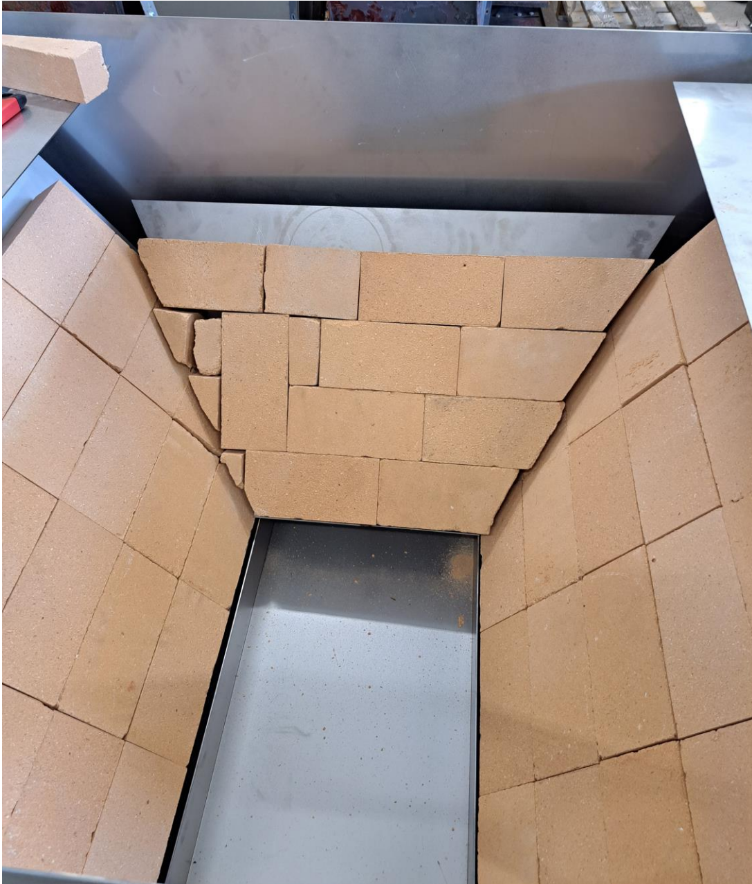
KUVA 15 Tiilien asettelu polttopesään.
