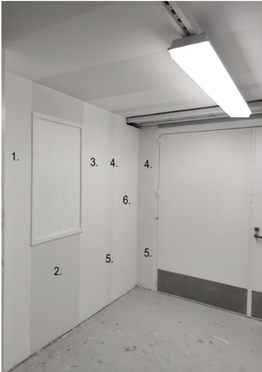
Kuva 4. Kuvassa tuotteet maalattuna koealueen vasemmalle puolelle. 1.Uula himmeä sisustusmaali, 2. liimamaali, 3. Coloria himmeä sisustusmaali, 4. pella-vaöljymaali, 5. kiinanpuuöljymaali sekä 6. Virtasen silkinhimeä sisustusmaali (Kuva: Jaana Virta 2023).
