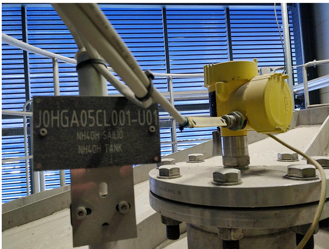
Kuva 6. Pinnanmittaustutkan laitepositio.
