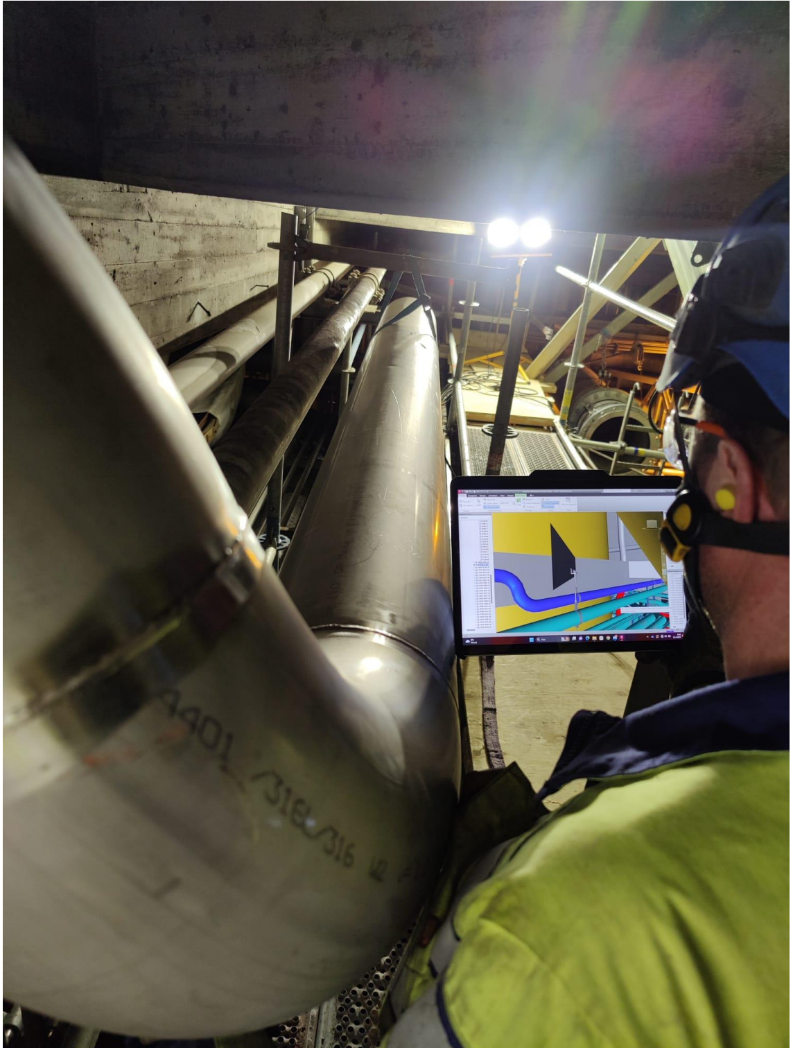
Kuvio 14. 3D-mallin tarkastamista asennuspaikalla
