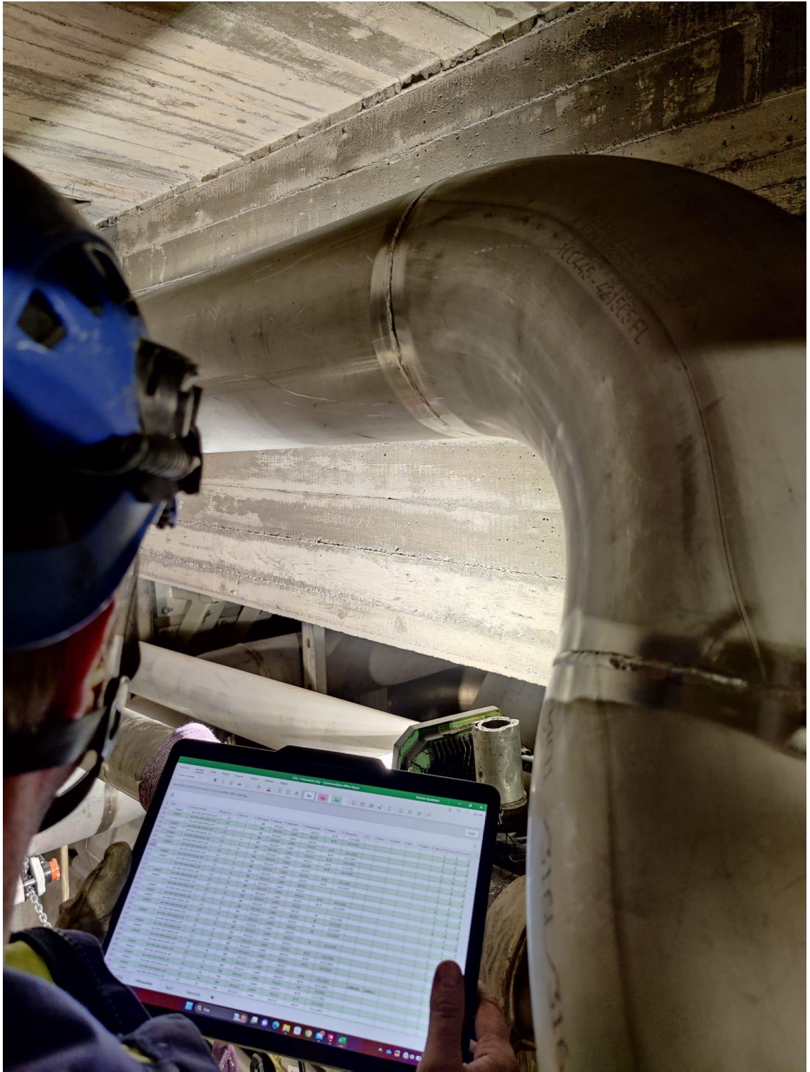
Kuvio 13. Hitsilokin täyttö asennusvaiheessa
