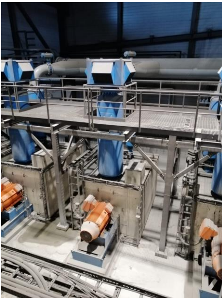
KUVA 1 Bloweri eli matalapainepuhallin
